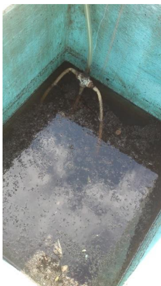
Figura 2.7. Detalhe da mangueira perfurada submersa dos reatores aerados
