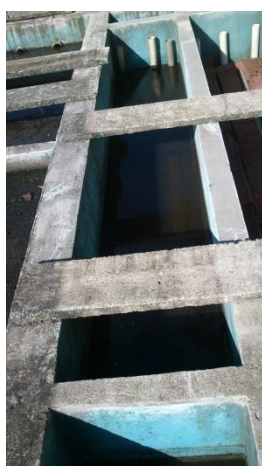
Figura 2.3. Reator anaeróbio
