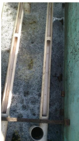
Figura 2.7. Detalhe da mangueira perfurada submersa dos reatores aerados
