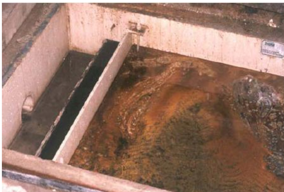
Figura 1 – Separador Água-óleo
