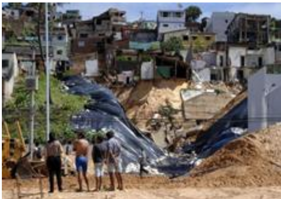
Figura 2. Imagens do impacto gerado pela erosão.
