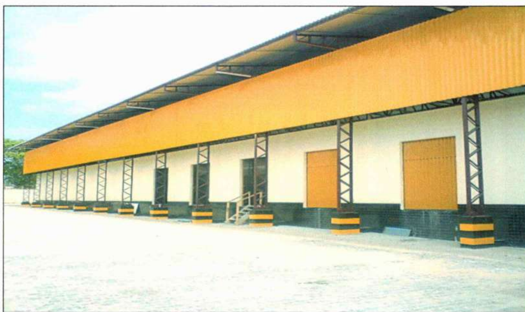
Figura 29: Nova estrutura de armazenagem Fonte: Uvifrios/2008
