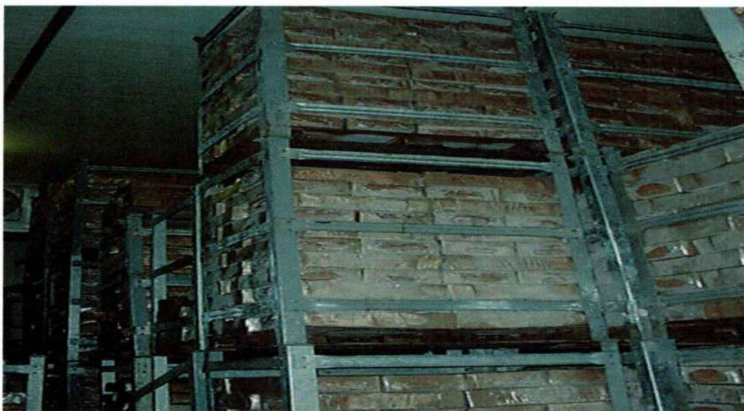
Figura 24: Armazenagem de produtos (câmara fria) Fonte: Uvifrios/2007
