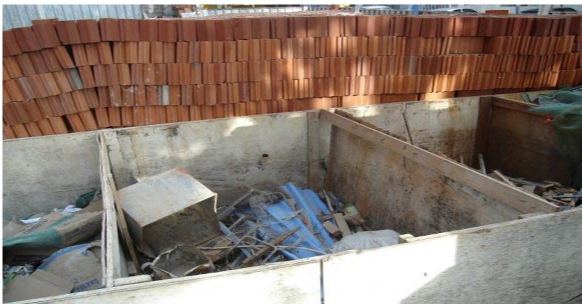
Figura 3 - Vista superior da baía, contendo restos de resíduos de construção civil, exemplo a ser seguido pela construtora em estudo.
