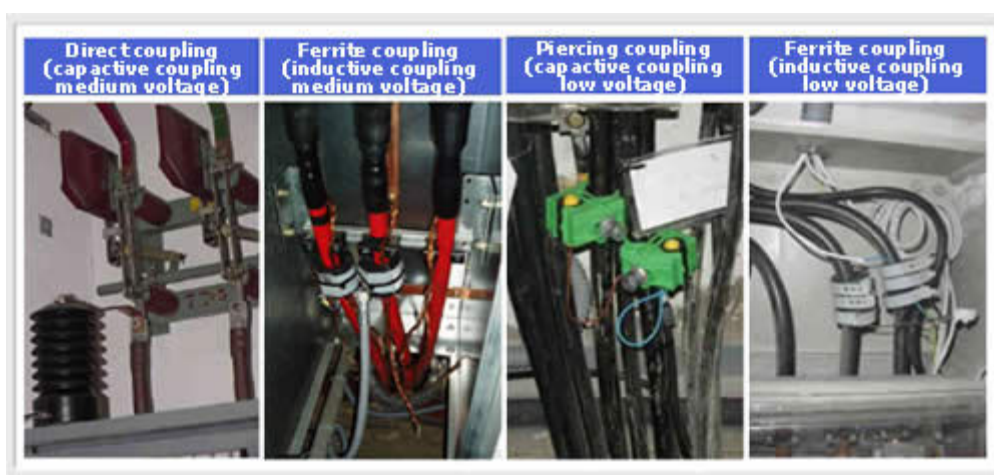
Figura 6: Exemplos de acopladores.
