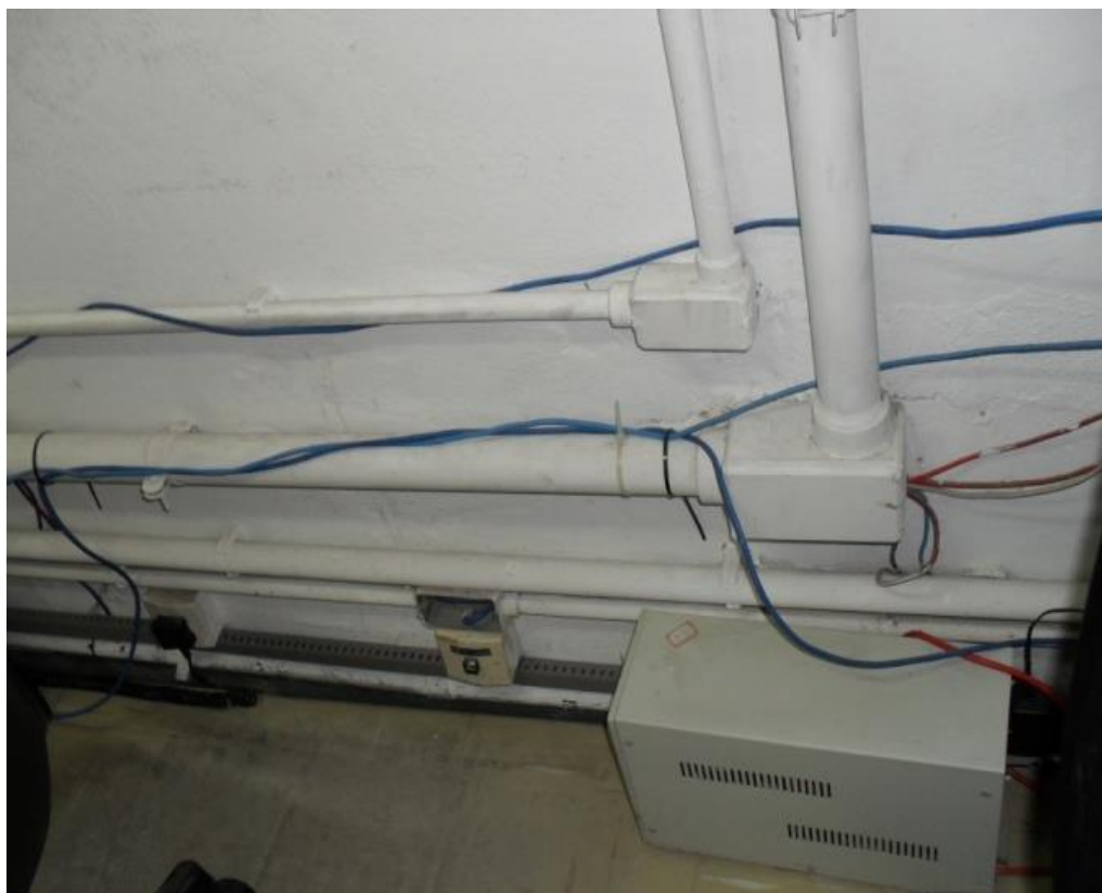
Imagem 2 - Acondicionamento de Cabos UTP
