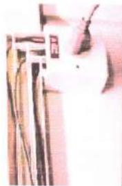
Exemplo de canaleta externa para passagem da fiação elétrica
