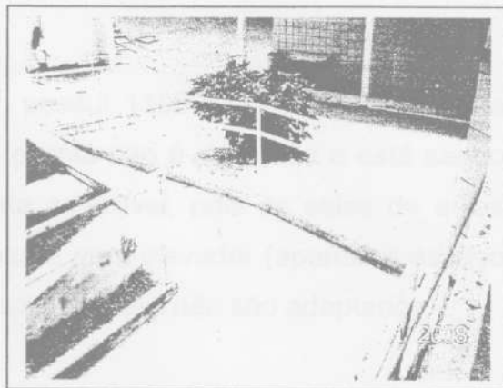
Fig.3 (E3) - Rampas de acesso à quadra
