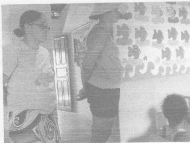
Figura 1: BS "A entrada em sala de aula" mostrando ausência de porta
