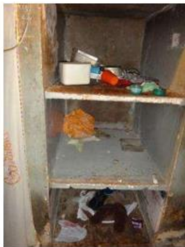
Comida indevidamente armazenada Foto 1
