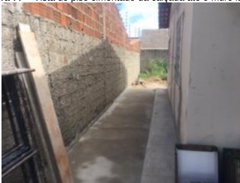
Figura 77 – Vista do piso cimentado da calçada até o muro lateral.
