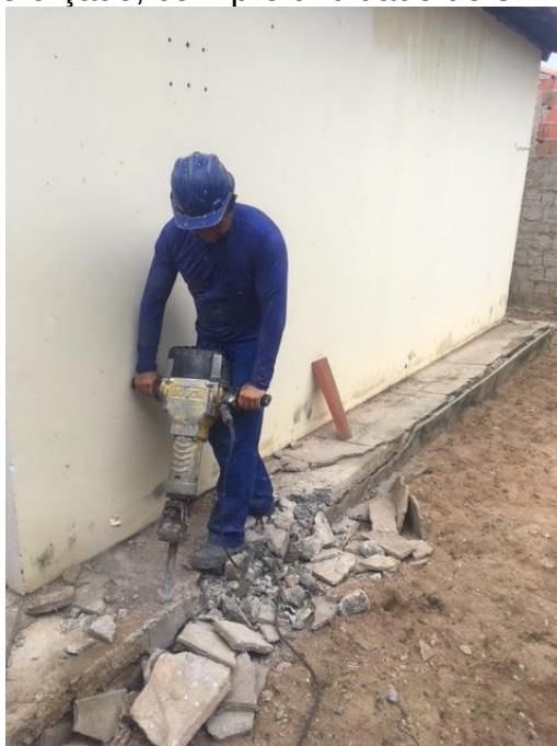
Figura 74 – Quebra da extremidade do radier (calçada) para ter acesso ao solo a ser reforçado, com profundidade de 3 metros.
