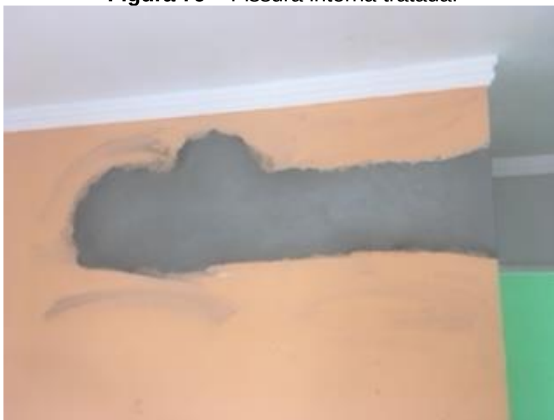
Figura 79 – Fissura interna tratada.
