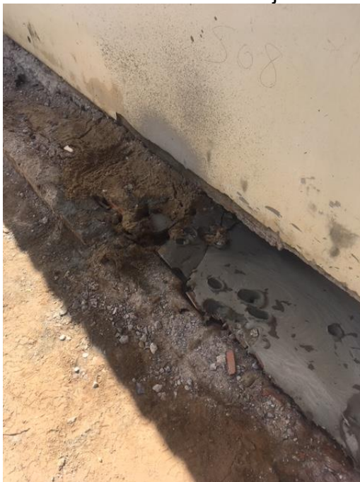
Figura 76 – Pasta de cimento injetada no solo.
