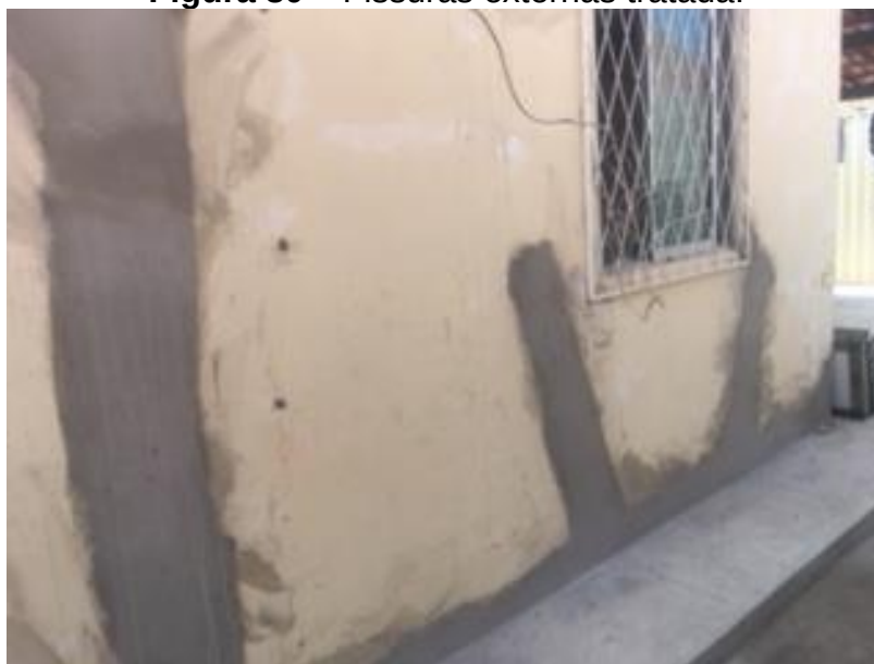
Figura 80 – Fissuras externas tratada.
