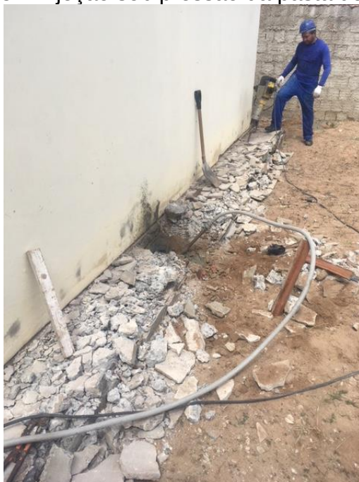
Figura 75 – Injeção sob pressão da pasta de cimento.
