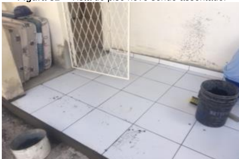
Figura 81 – Vista do piso novo sendo assentado.
