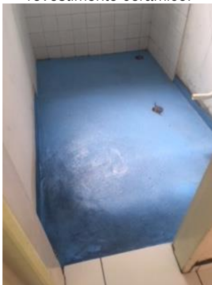
Figura 82 – Piso do banheiro impermeabilizado, esperando assentamento do revestimento cerâmico.
