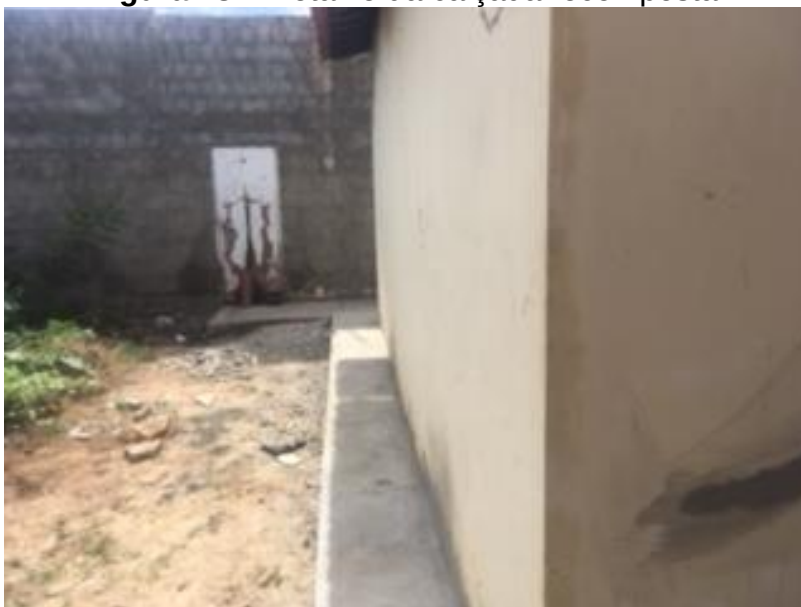
Figura 78 – Detalhe da calçada recomposta.
