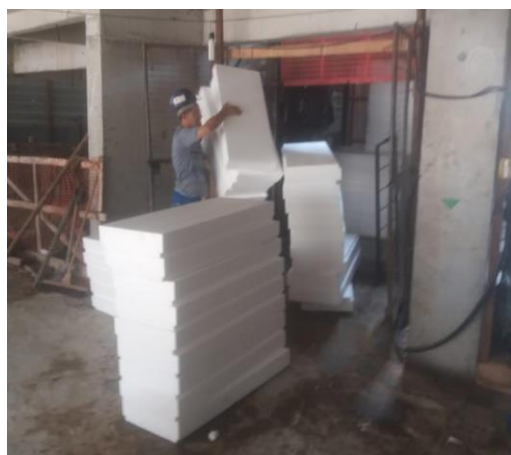
Figura 21- Transporte no elevador das lajetas de EPS.
