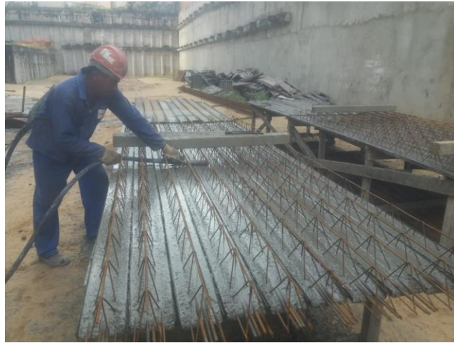
Figura 16- Vibração do concreto na confecção das treliças
