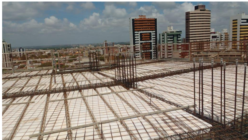
Figura 13 -Laje unidirecional com utilização de EPS.
