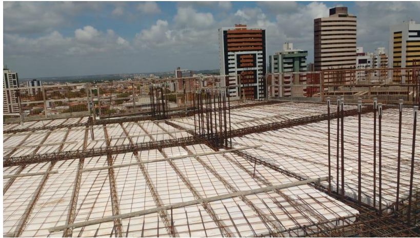
Figura 25- Laje pronta para concretagem
