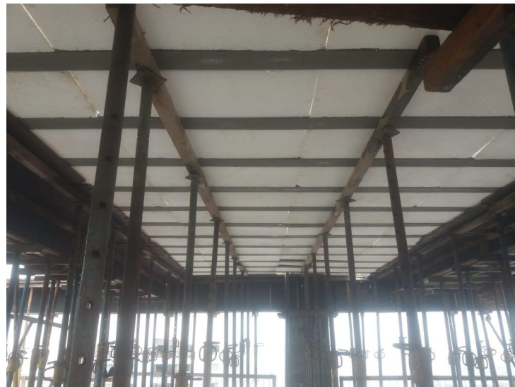
Figura 24 -Escoramento da laje treliçada com utilização de EPS.
