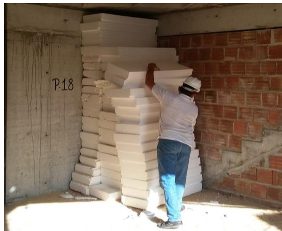
Figura 20- Armazenamento dos blocos de EPS.
