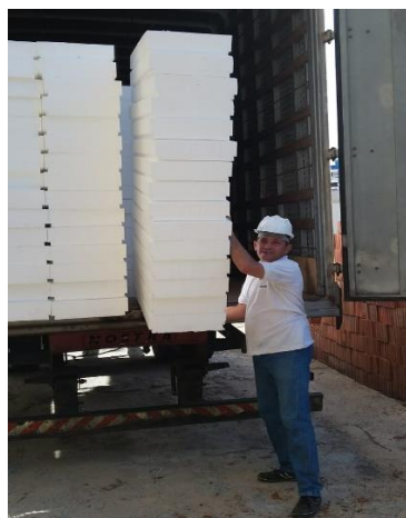
Figura 19 -Transporte e descarga do EPS na obra
