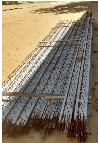
Figura 17- Treliças finalizadas e propícia para o uso
