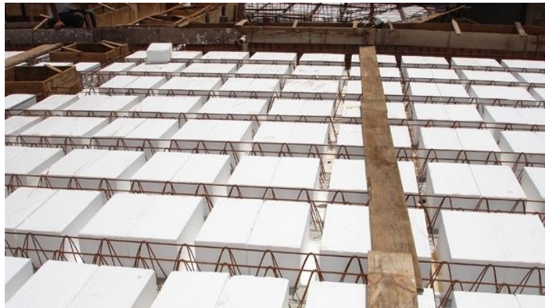
Figura 14 -EPS em laje bidirecional
