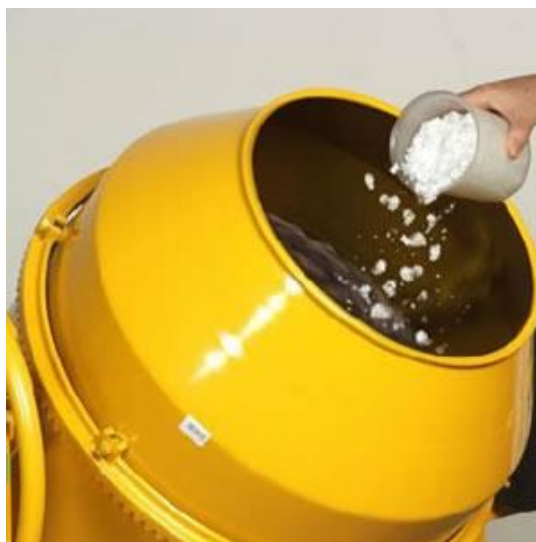
Figura 11-Fabricação do concreto leve
