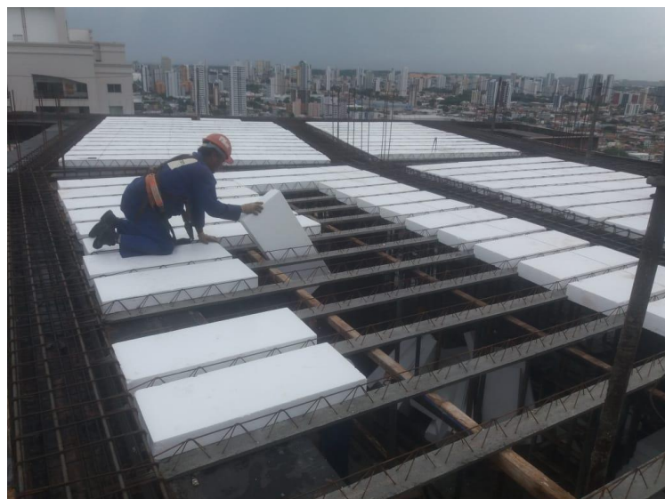
Figura 23 -aplicação das lajotas de EPS na laje.
