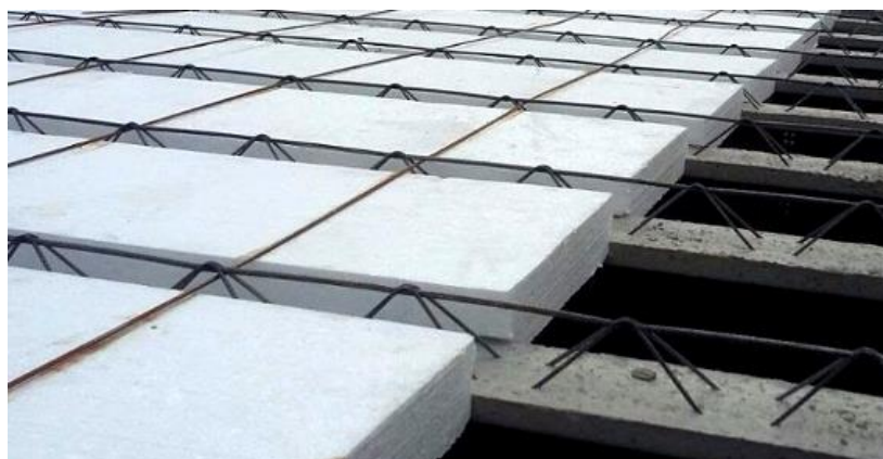
Figura 5-Blocos de EPS em lajes treliçadas
