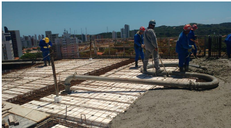
Figura 26- Concretagem das lajes treliçadas.
