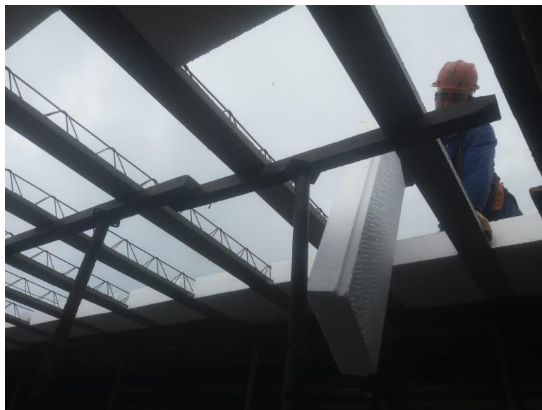
Figura 22 -aplicação das lajotas de EPS na laje.
