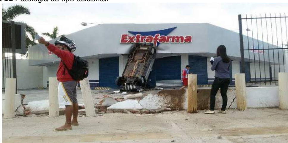
Figura 11 Patologia do tipo acidental
