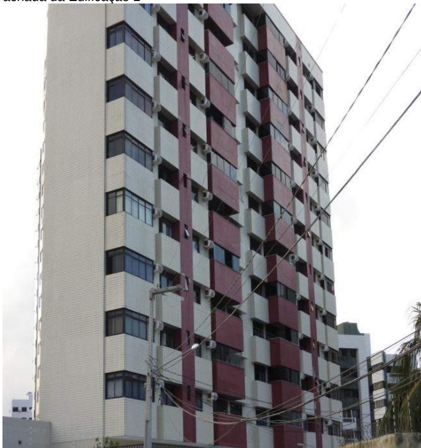
Figura 43 Fachada da Edificação 1
