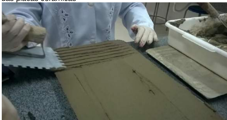
Figura 15 Assentamento da argamassa industrial colante ACI do fabricante "A" para o assentamento das placas cerâmicas
