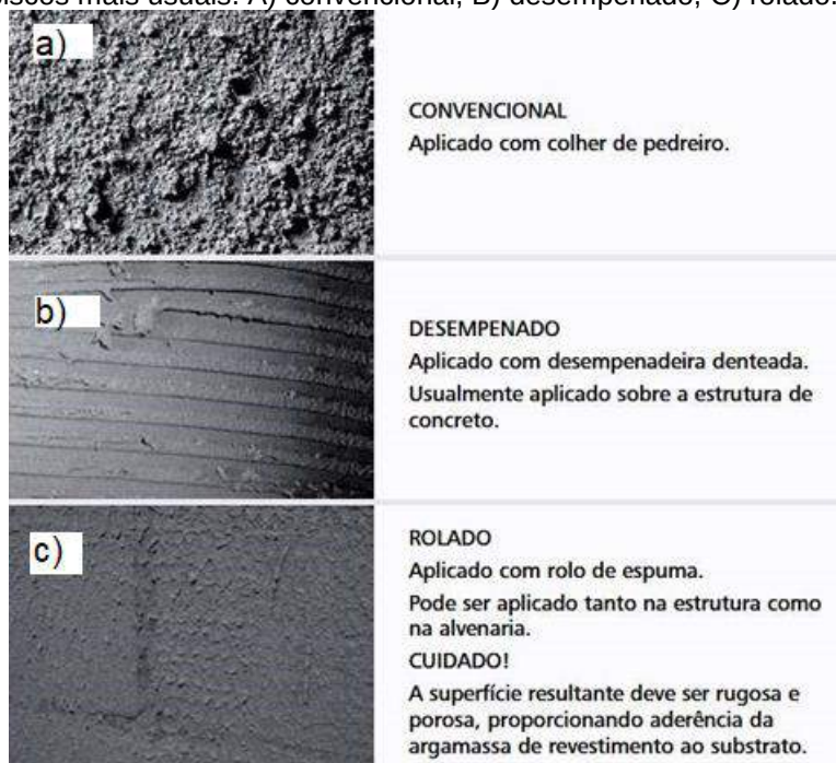
Figura 4 Chapiscos mais usuais. A) convencional, B) desempenado, C) rolado.
