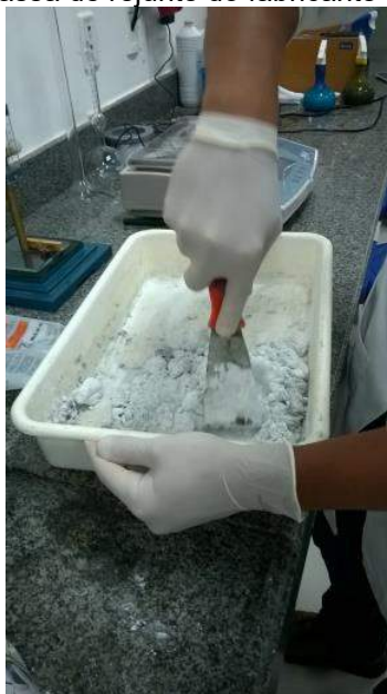
Figura 37 Preparação da argamassa de rejunte do fabricante "A"
