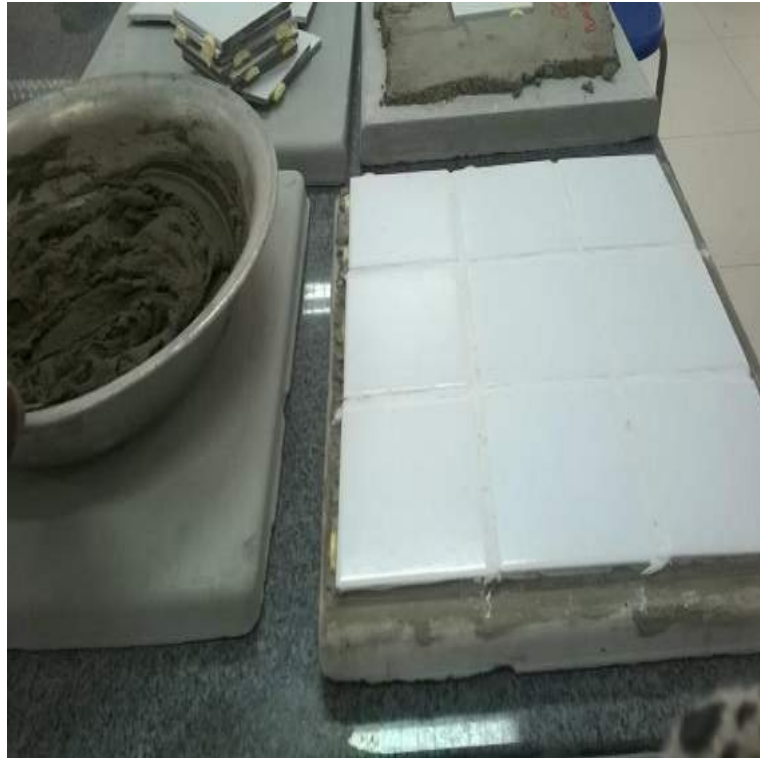
Figura 35 Assentamento cerâmico para colocação da argamassa colante industrial piso sobre piso do fabricante “B”
