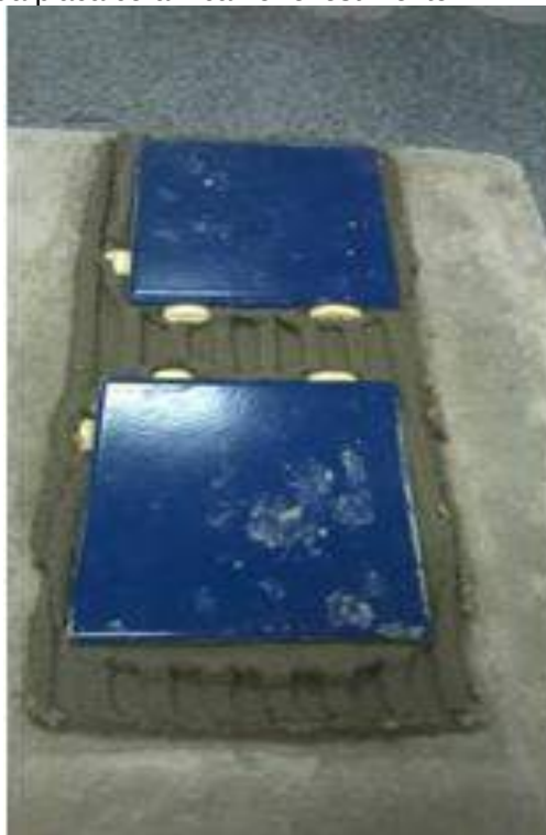
Figura 25 Assentamento da placa cerâmica no revestimento
