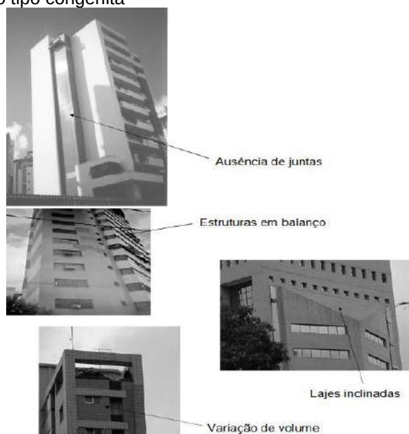
Figura 8 Patologia do tipo congênita
