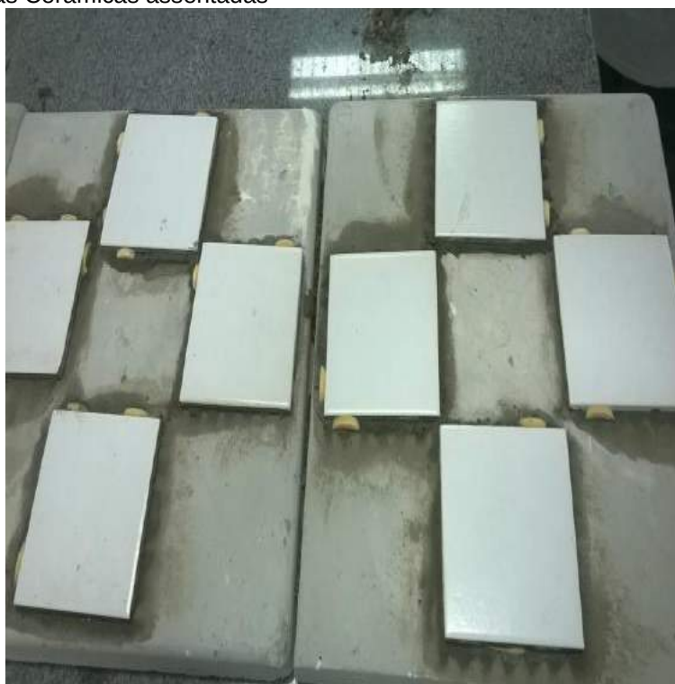
Figura 21 Placas Cerâmicas assentadas
