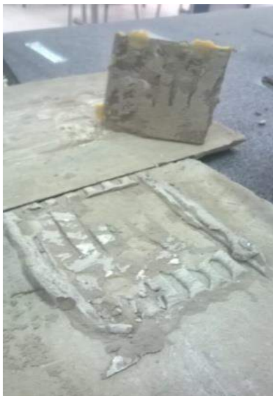
Figura 22 Arrancamento do Corpo de prova da argamassa colante industrial ACII do fabricante "A"
