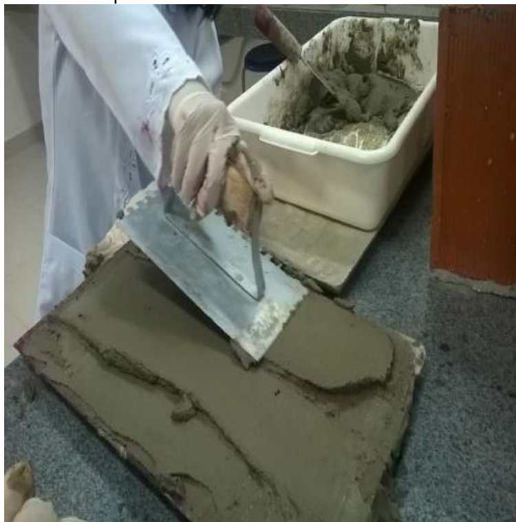
Figura 20 Preparação da argamassa colante industrial para revestimento externo do fabricante “A” para o assentamento das placas cerâmicas
