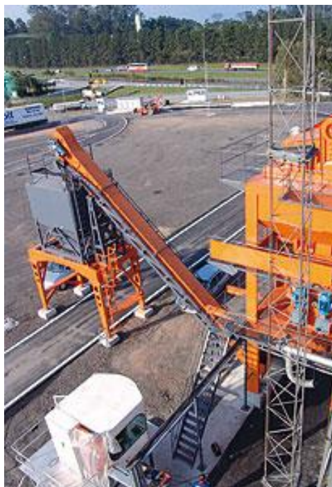
Figura 5 – Aplicação do Asfalto Borracha, Rodovias Imigrantes, em SP Capital
