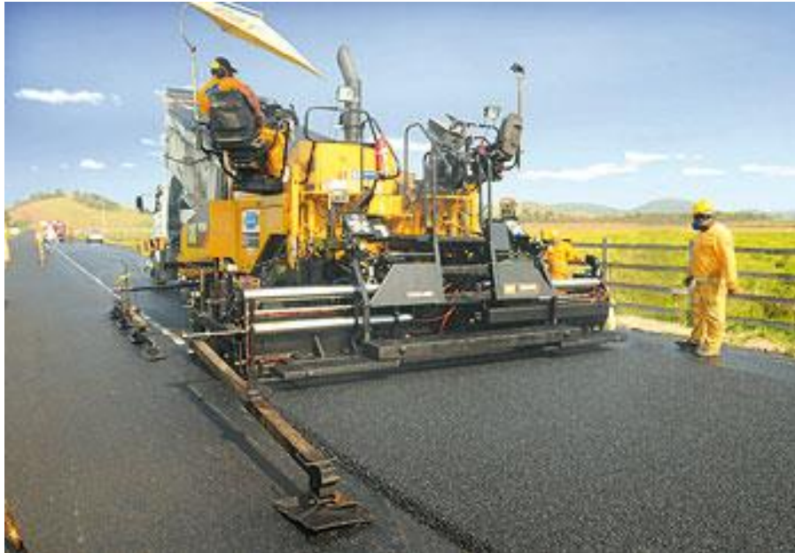
Figura 6 – Restauração da Rodovia RJ-122 Realizada com Asfalto Borracha
