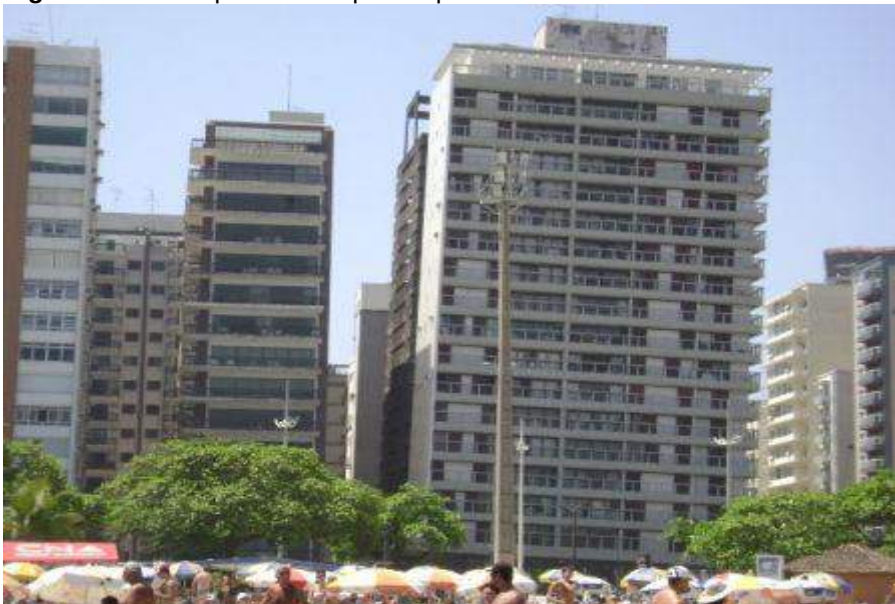
Figura 13 - Exemplo de desaprumo presente na Orla de Santos
