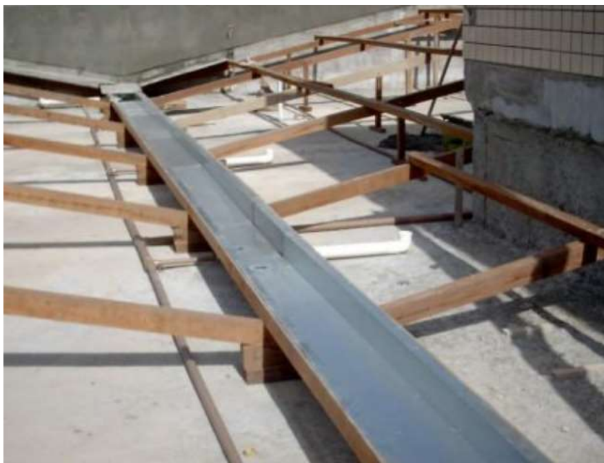
Figura 3 – Calha central retangular metálica
