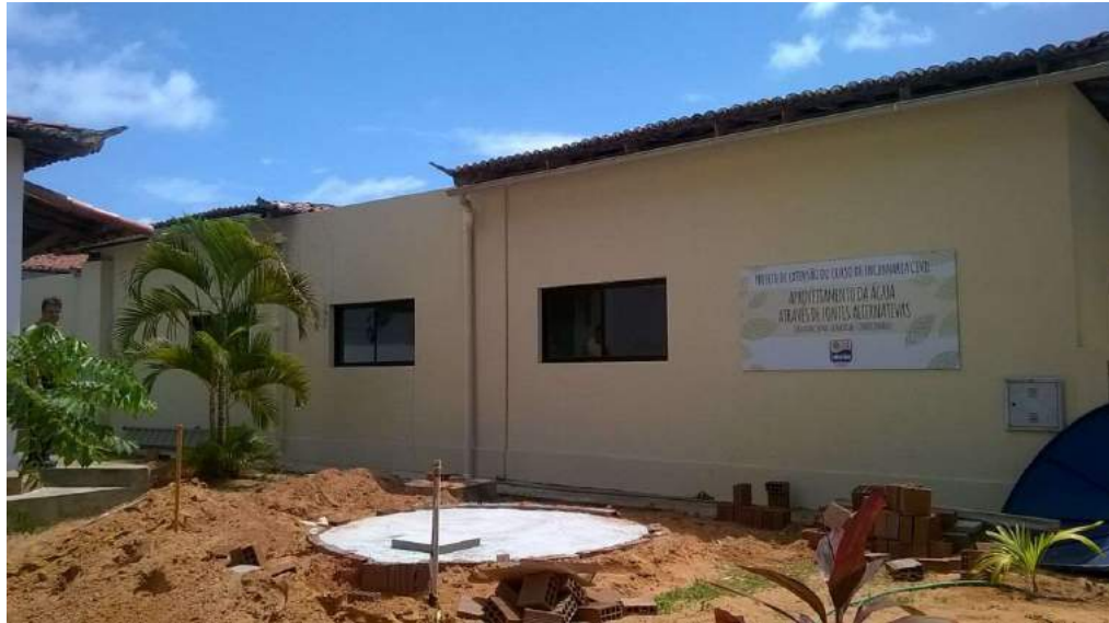
Figura 15 – Elementos Componentes do Sistema Instalado no UNI-RN
