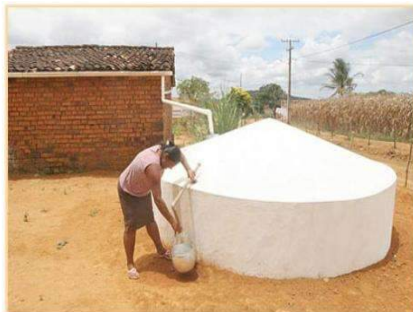
Figura 9 – Reservatório em alvenaria
