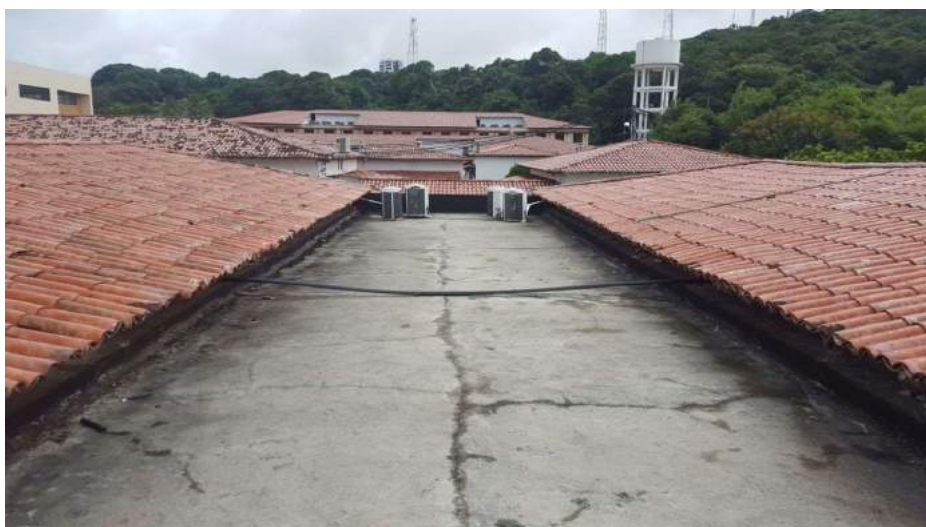
Figura 19 – Laje impermeabilizada entre as coberturas
