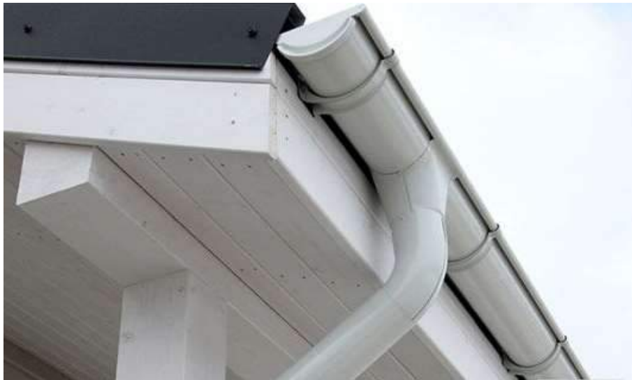
Figura 2 – Calha de beiral semicircular de PVC e tubo de queda
