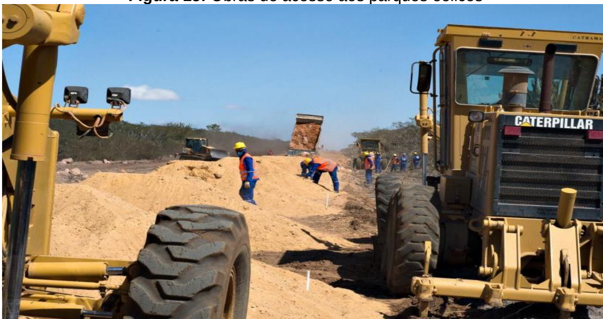
Figura 15: Obras de acesso aos parques eólicos
