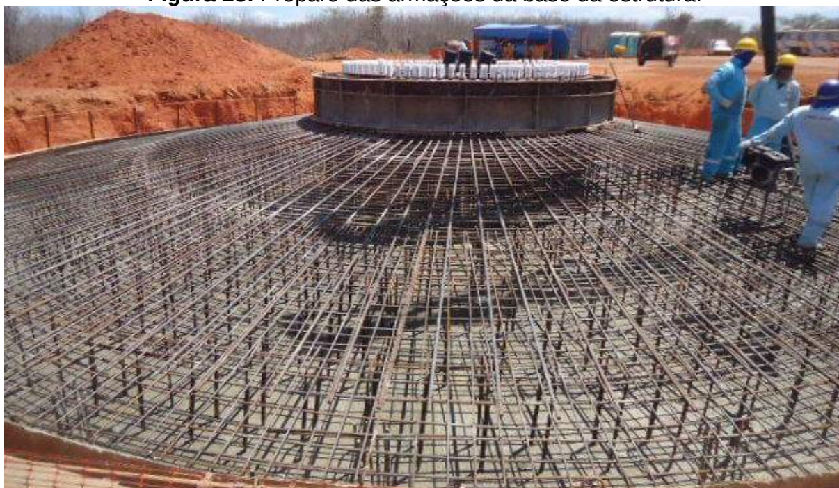
Figura 28: Preparo das armações da base da estrutura.
