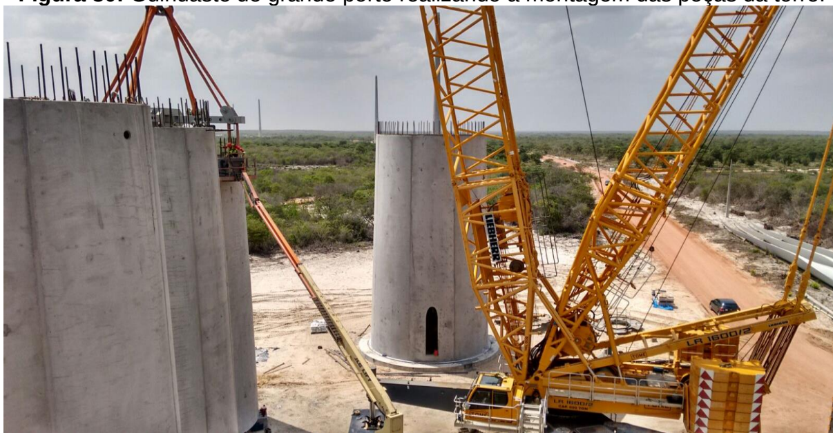
Figura 30: Guindaste de grande porte realizando a montagem das peças da torre.
