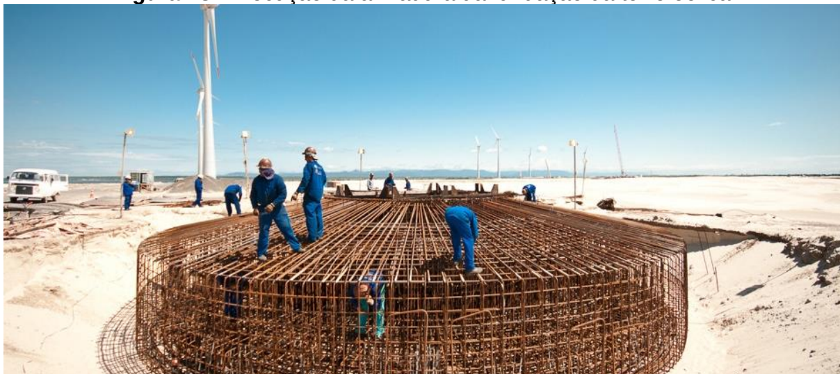
Figura 18: Execução da armadura da fundação da torre eólica.
