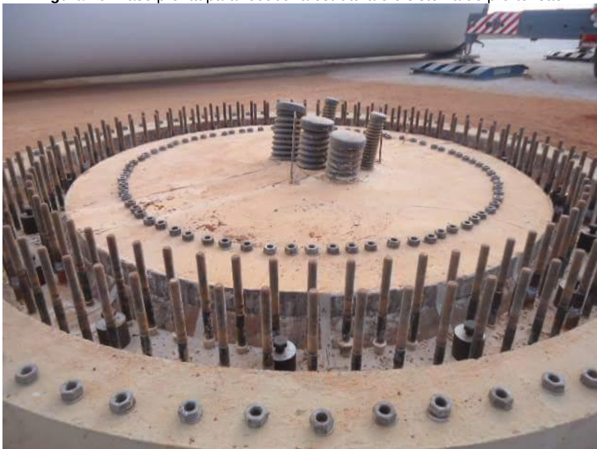
Figura 29: Base pronta para receber a estrutura e o sistema de pró-tensão.
