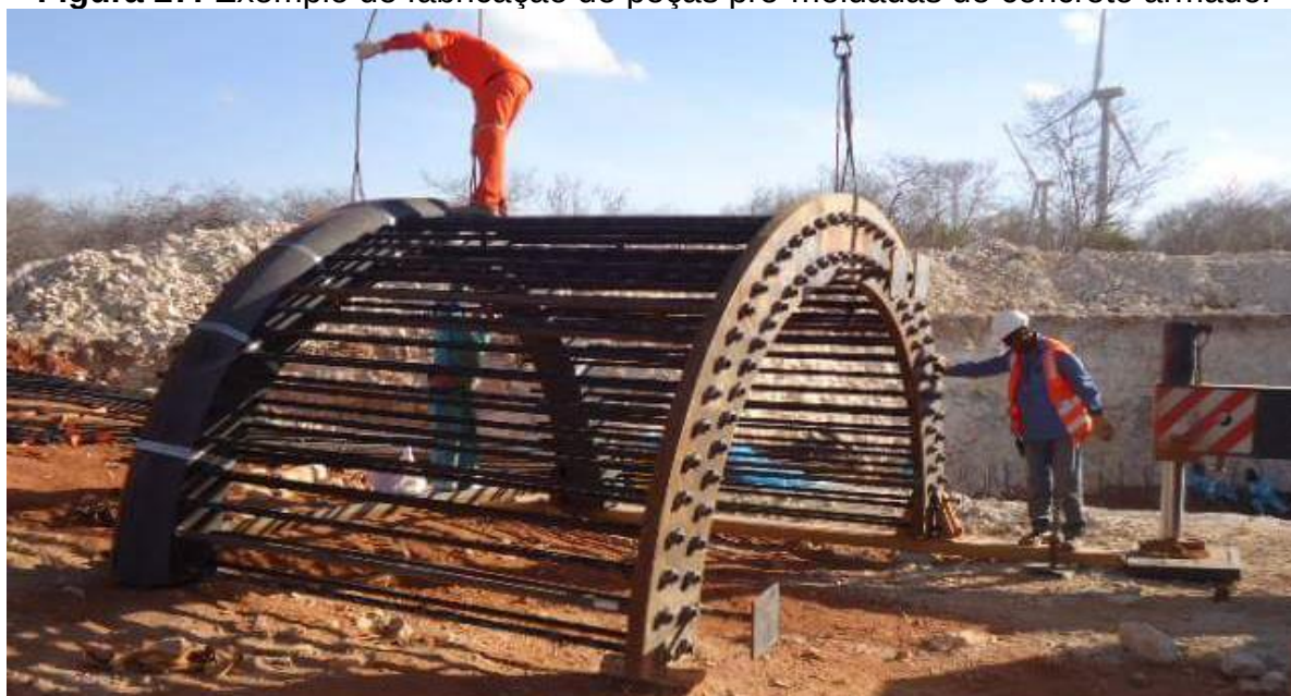
Figura 27: Exemplo de fabricação de peças pré-moldadas de concreto armado.
