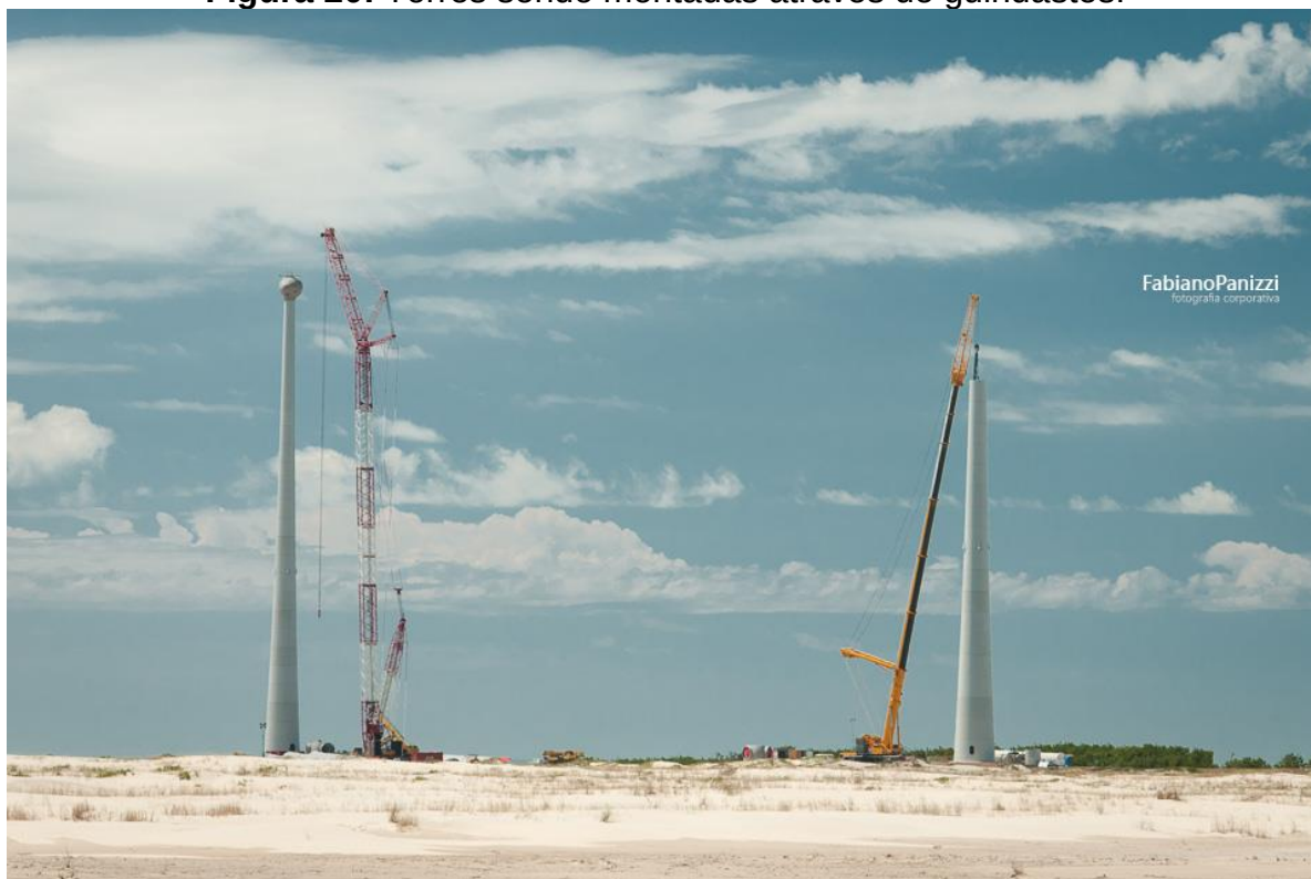
Figura 20: Torres sendo montadas através de guindastes.
