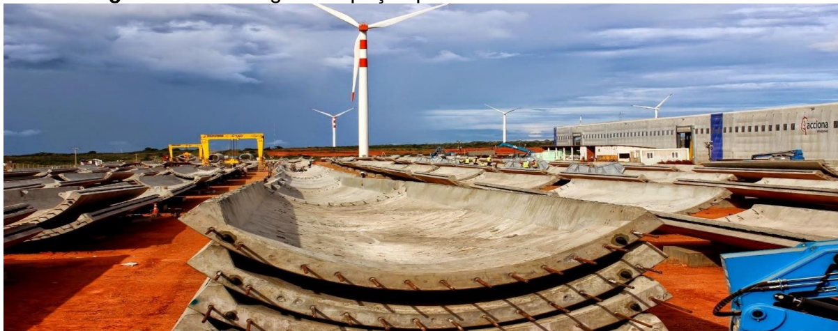
Figura 24: Estocagem de peças pré-moldadas de concreto armado.
