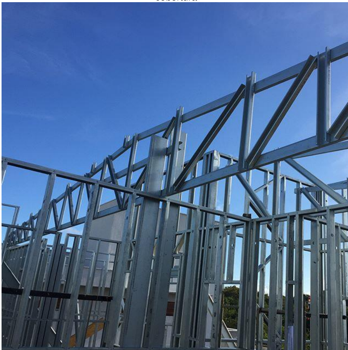
Figura 2 – Detalhe da cobertura
