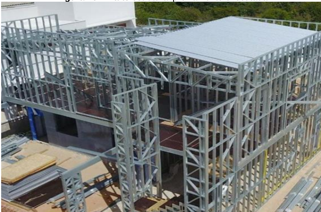
Figura 29 – Parte estrutural previamente executada
