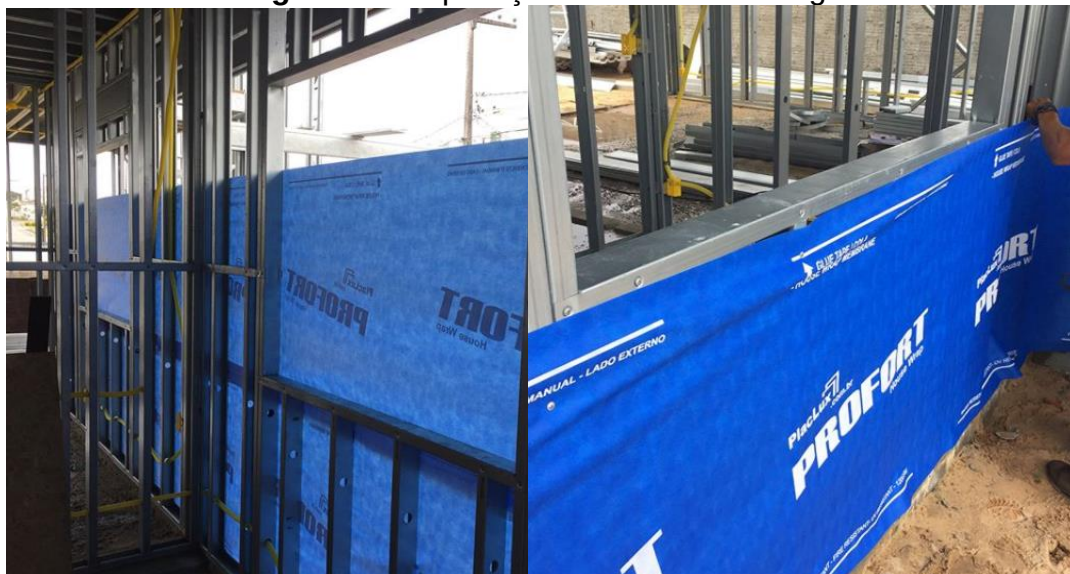
Figura 30 – Aplicação de manta hidrófuga
