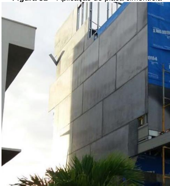
Figura 31 – Aplicação de placa cimentícia
