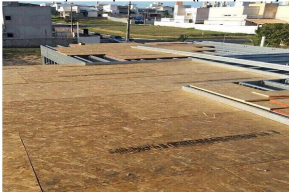
Figura 35 – Utilização da placa OSB (pinus) na laje semi-seca
