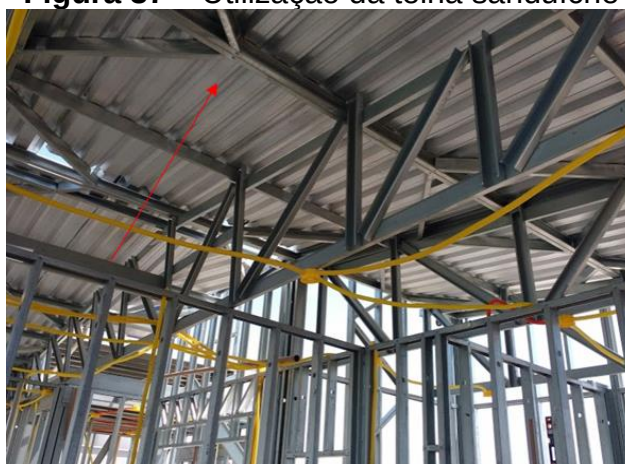
Figura 37 – Utilização da telha sanduíche
