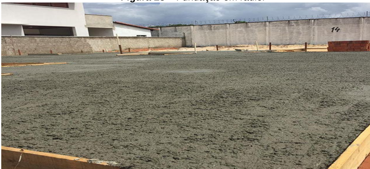
Figura 23 – Fundação em radier
