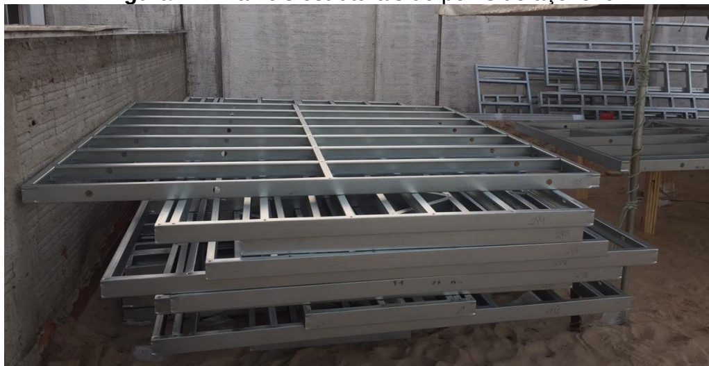
Figura 27 – Paineis estruturais de perfis de aço leve
