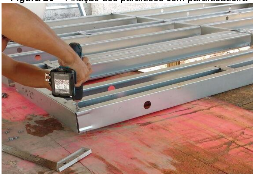
Figura 26 – Fixação dos parafusos com parafusadeira
