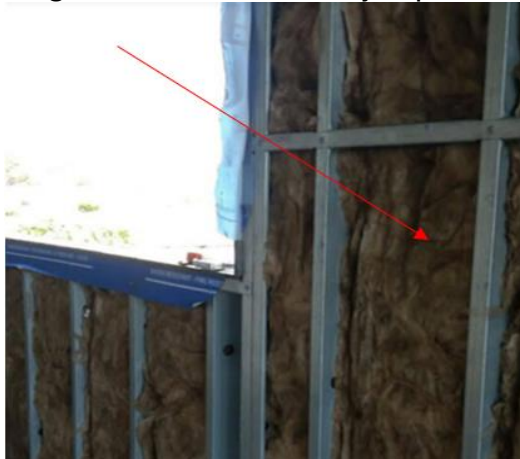
Figura 34 – Lã de vidro já aplicada
