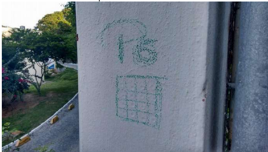
Figura 35 – Ensaio de esclerometria no pilar 6
