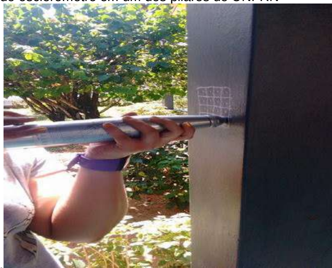
Figura 26 – Aplicação do esclerômetro em um dos pilares do UNI-RN
