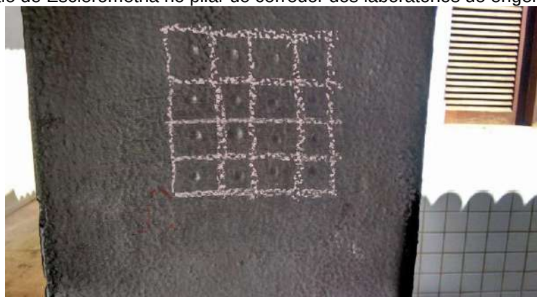
Figura 37 – Ensaio de Esclerometria no pilar do corredor dos laboratórios de engenharia do UNI-RN.
