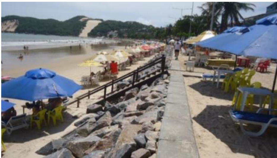
Figura 12 – Enrocamento aderente adotado na Praia de Ponta Negra, Natal/RN
