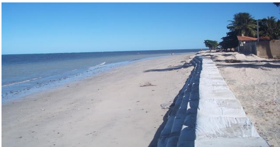
Figura 14 – Bagwall- Praia da Croa, Alagoas
