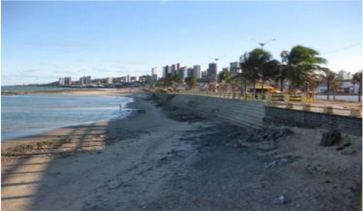
Figura 9 – Paredão também utilizado como arrimo, situado na Praia de Meio em Natal (RN)
