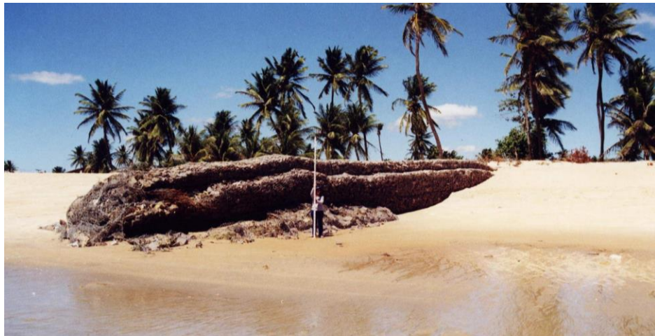
Figura 18 – Modelo de gabião utilizado na proteção da costa na praia de São Bento do Norte/RN
