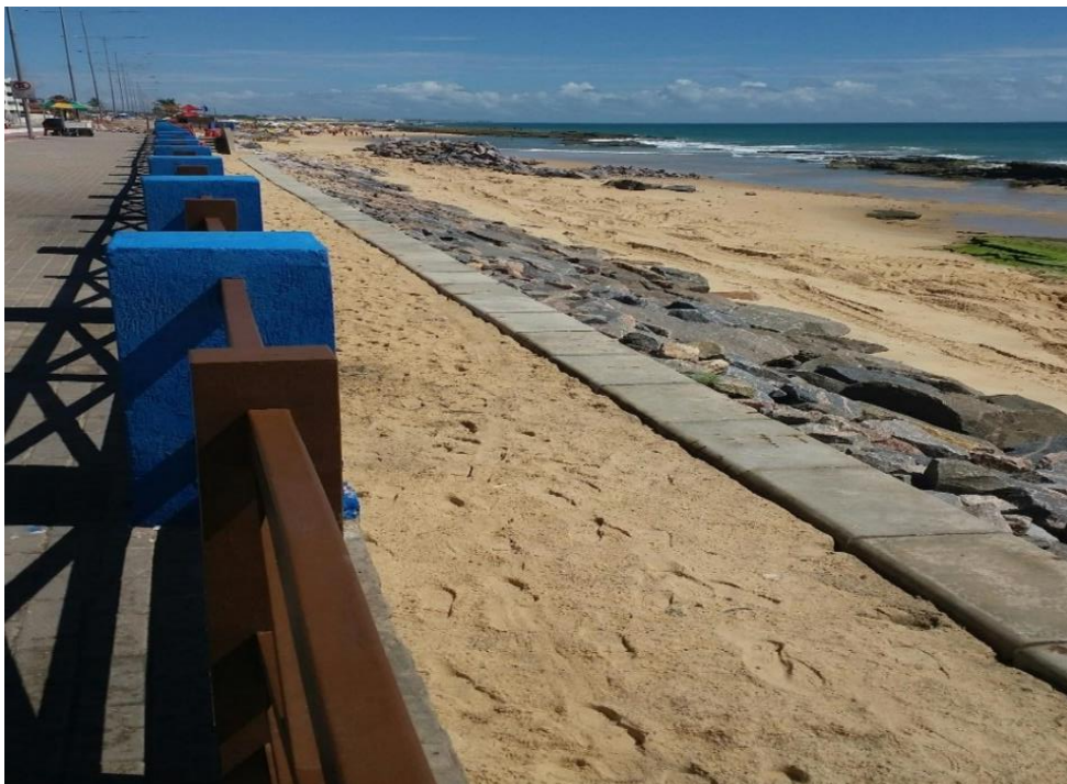
Figura 19 – Enrocamento no primeiro trecho sendo executado
