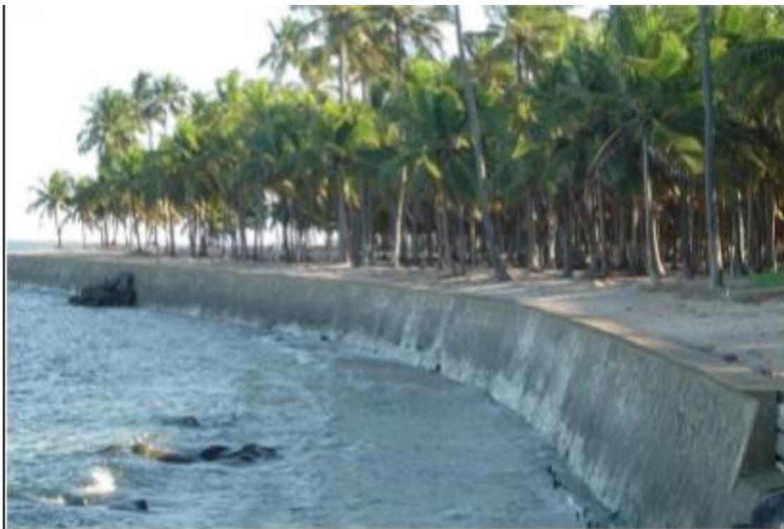
Figura 10 – Estrutura tipo de bulkhead
