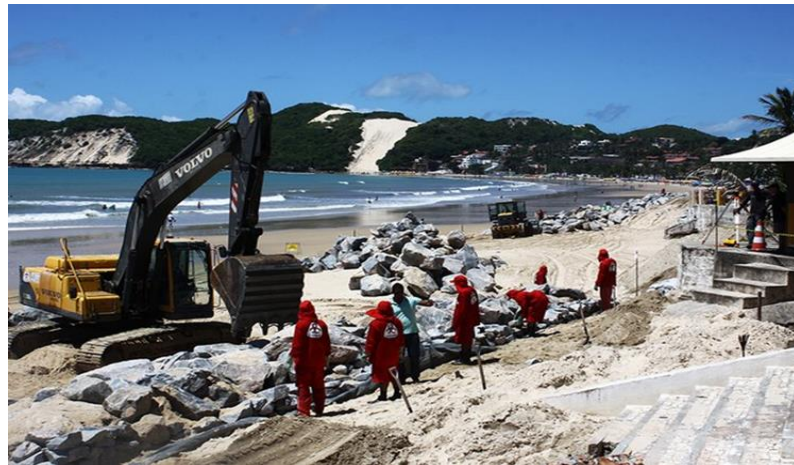
Figura 2 – Obra de proteção costeira (enrocamento) arrumado de pedras na praia de Ponta Negra, Natal/RN
