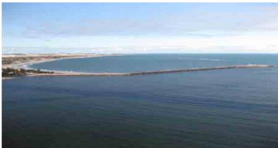
Figura 8 – Guia Corrente localizado na entrada do porto de Natal-RN
