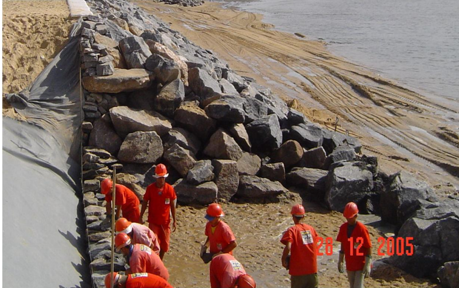
Figura 21 – Elevação manual da camada de suporte do geotêxtil. Extraído do Projeto de contenção do processo de erosão marinha e estabilização da linha de costa na praia de Ponta Negra (2013)
