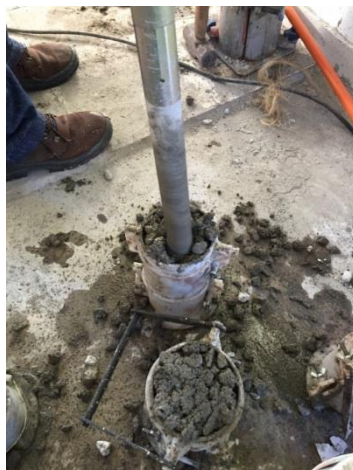
Figura 8 – Corpos de prova sendo adensados
