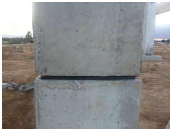
Figura 37 - Vista de uma junta de dilatação
