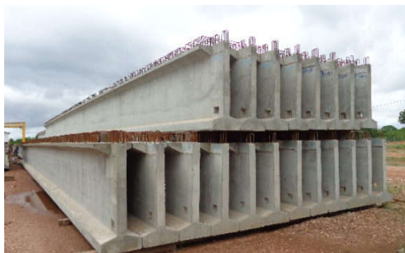
Figura 17 – vigas protendidas
