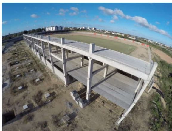
Figura 31 – Vista da construção das lajes
