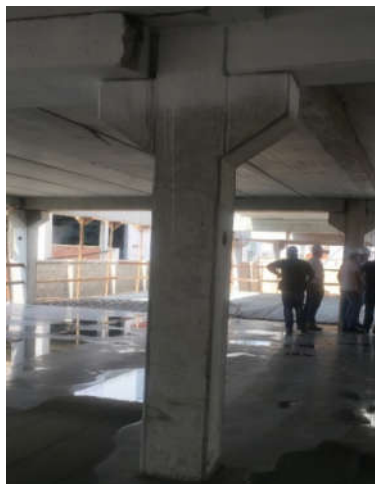
Figura 1- Pilar e viga de concreto pré-moldado
