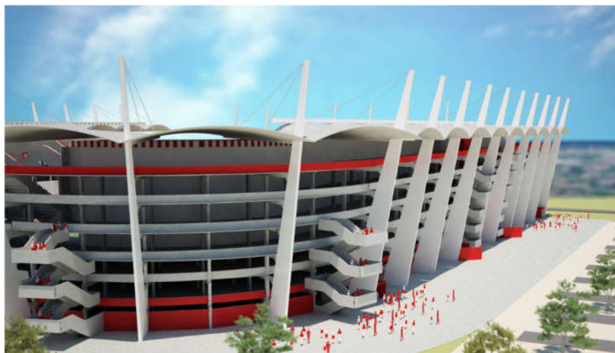
Figura 41 - Pórticos com tirantes segurando a cobertura em forma de casca
