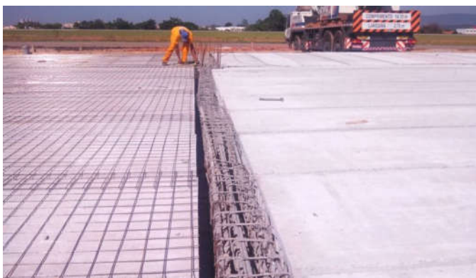
Figura 21 – Laje maciça pré-moldada
