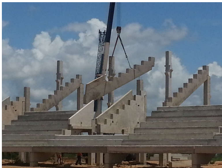
Figura 35 - Detalhe da montagem das vigas jacaré com os degraus no estádio
