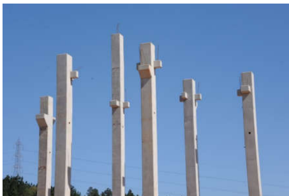
Figura 10 – Pilares pré-moldados
