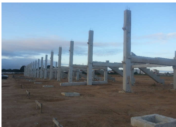
Figura 36 - Vista dos pilares
