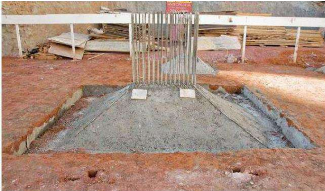
Figura 3 – Execução de sapata isolada
