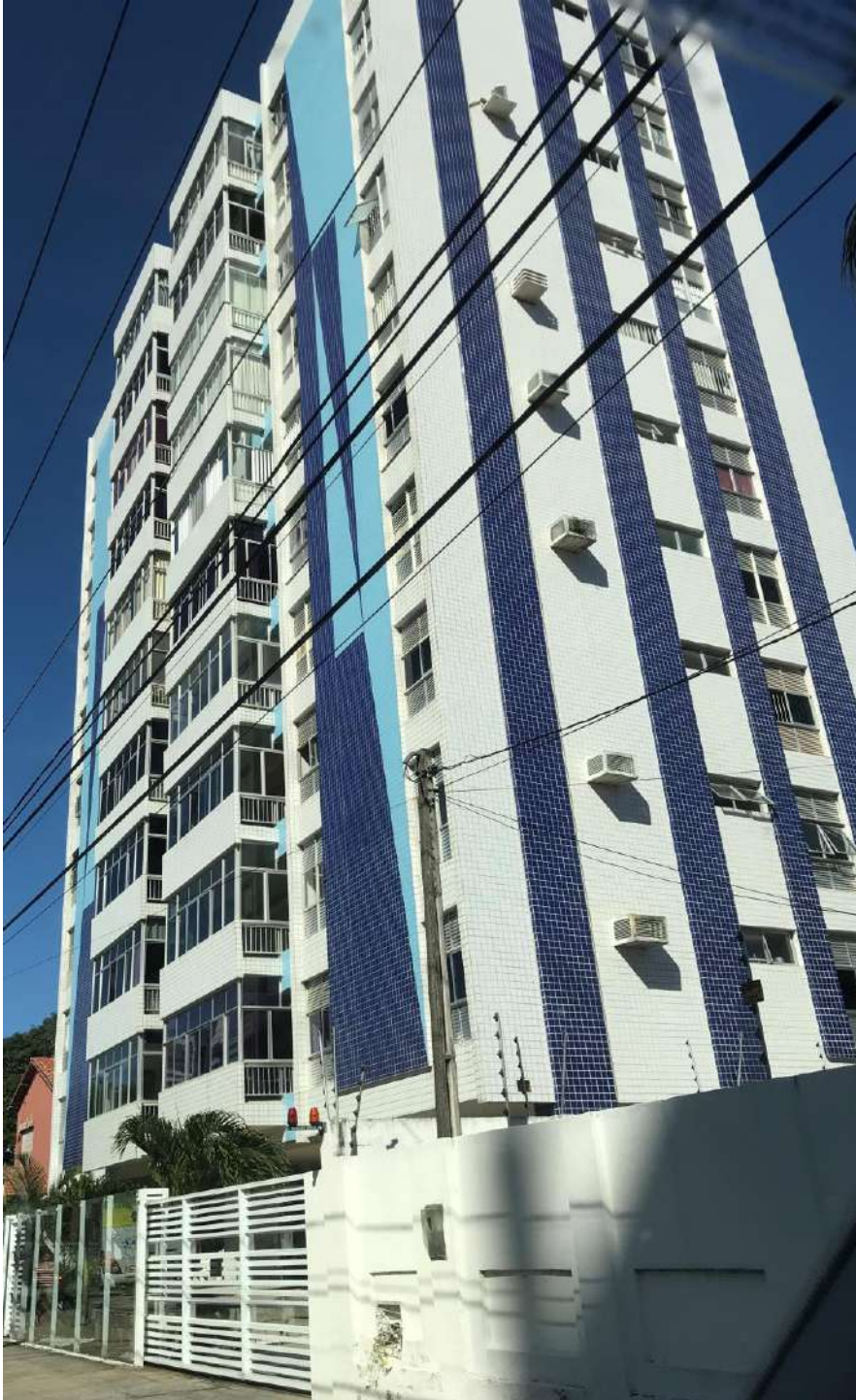
Figura 17: Vista da fachada do edifício C.
