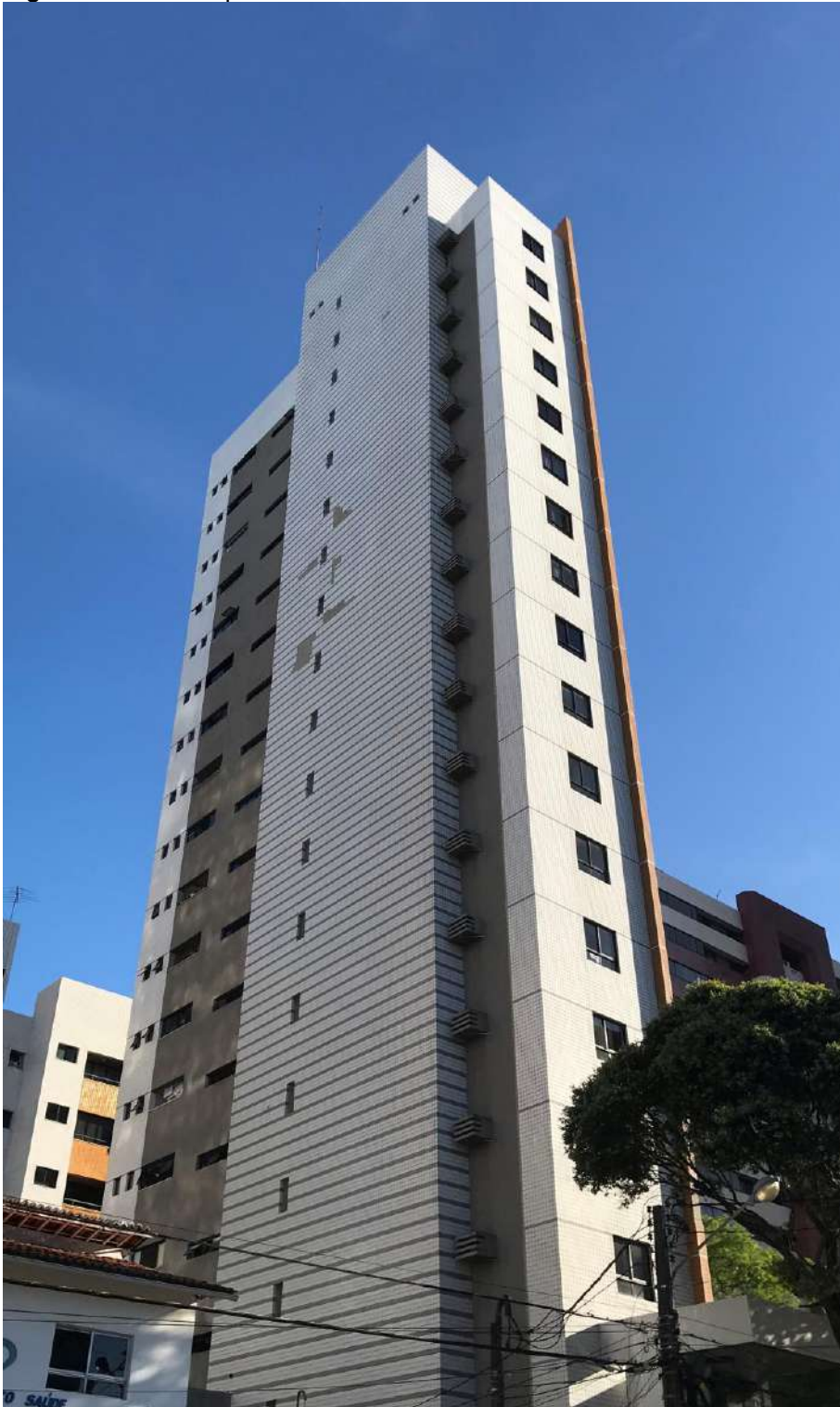
Figura 14: Vista da parte anterior da fachada com destacamento.
