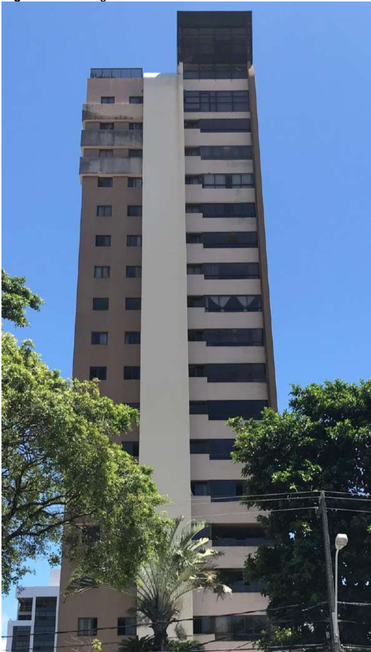
Figura 11: Vista geral da fachada com manchas e mofo.
