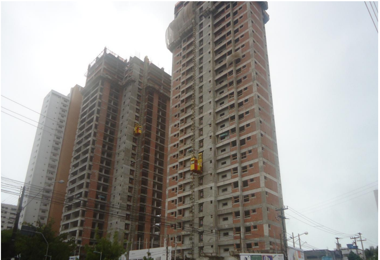
Figura 7 – Duas torres em construção
