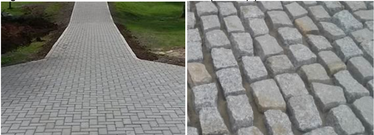
Figura 11 – Pavimento de bloco de concreto e paralelepípedo.
