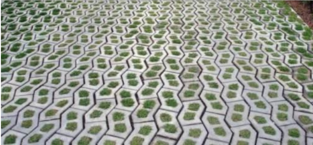
Figura 10 – Pavimento de bloco de concreto vazado.
