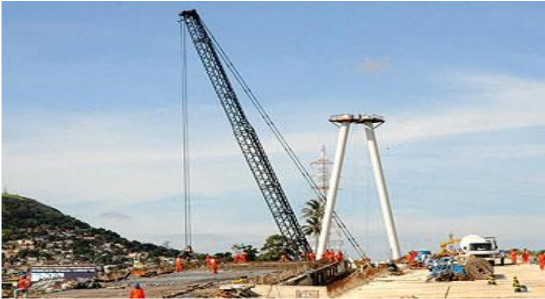
Figura 32 – Implantação de pilares
