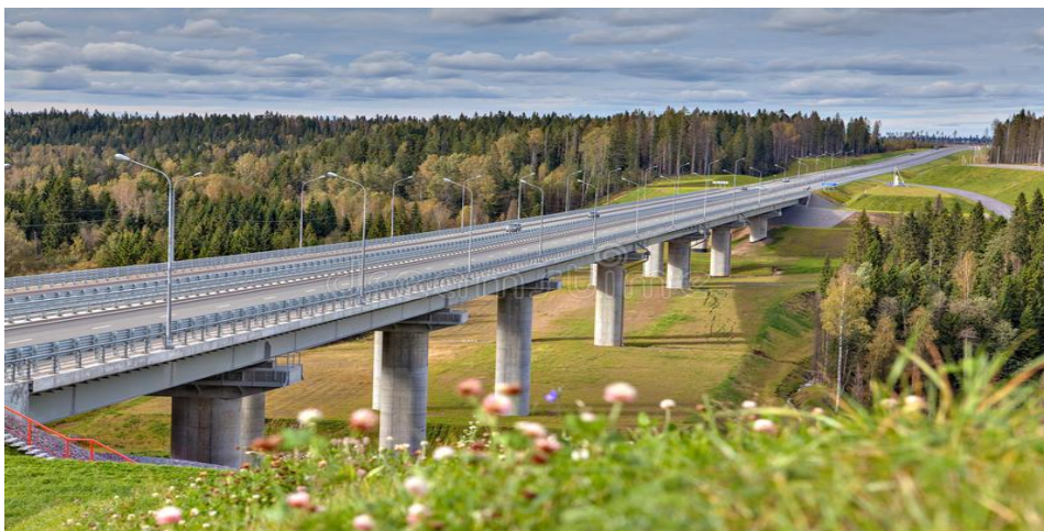
Figura 22 – Ponte em Viga
