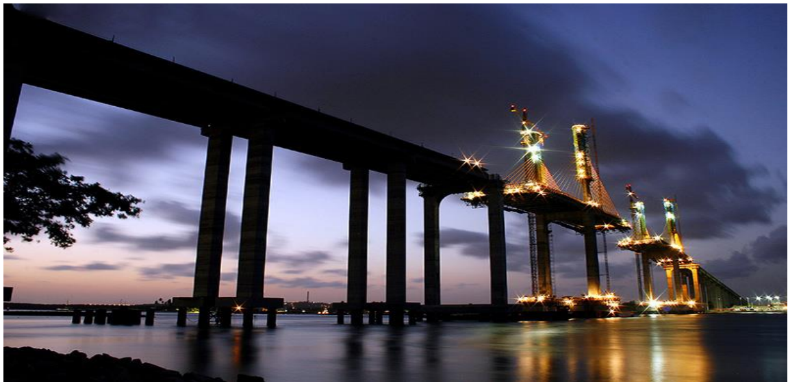
Figura 49 – Construção da Ponte Newton Navarro
