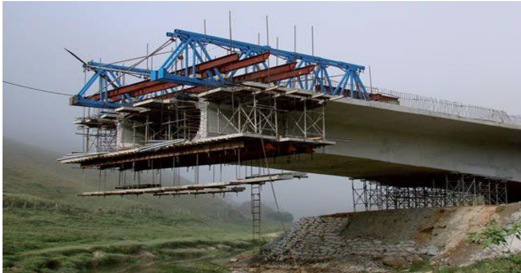
Figura 20 – Construção da Ponte sobre o Rio Claro (Brasil)
