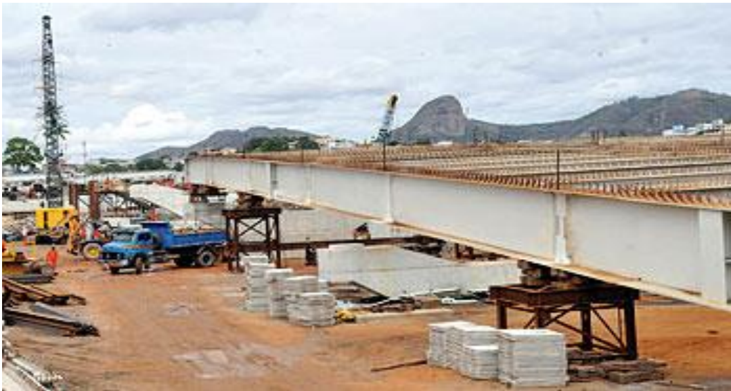
Figura 31 – Confeção do tabuleiro de ponte estaiada
