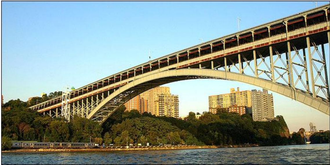
Figura 13 – Ponte Henry Hudson, Nova Yorke (USA)
