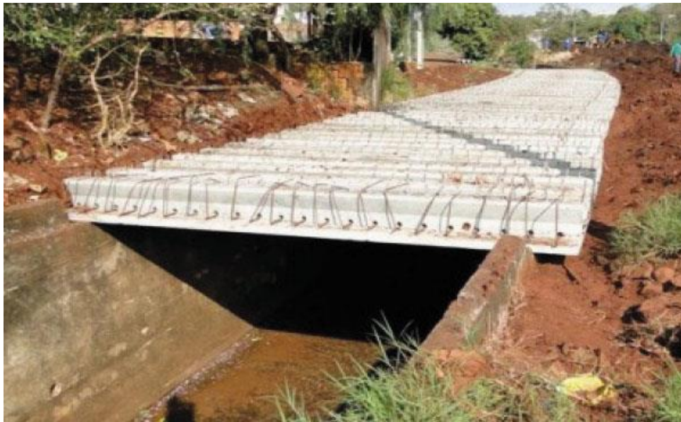
Figura 17 – Ponte de laje pré-moldada
