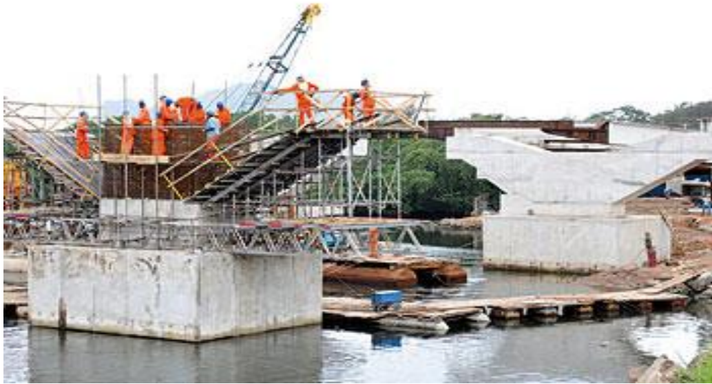
Figura 30 – Processo de ancoragem em bloco
