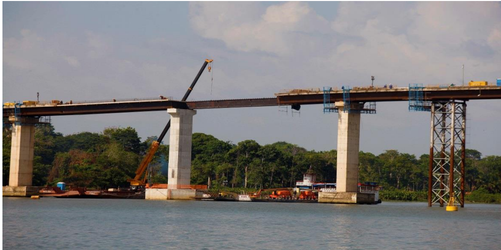
Figura 18 – Ponte de viga
