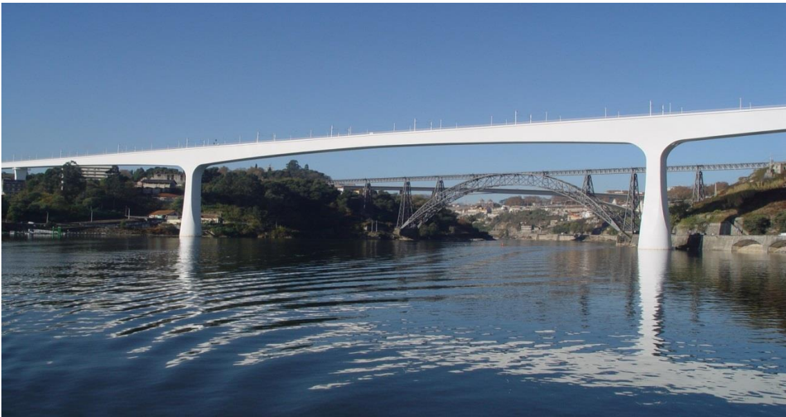
Figura 12 – Ponte Ferroviária São João, Rio Douro, Porto (Portugal)
