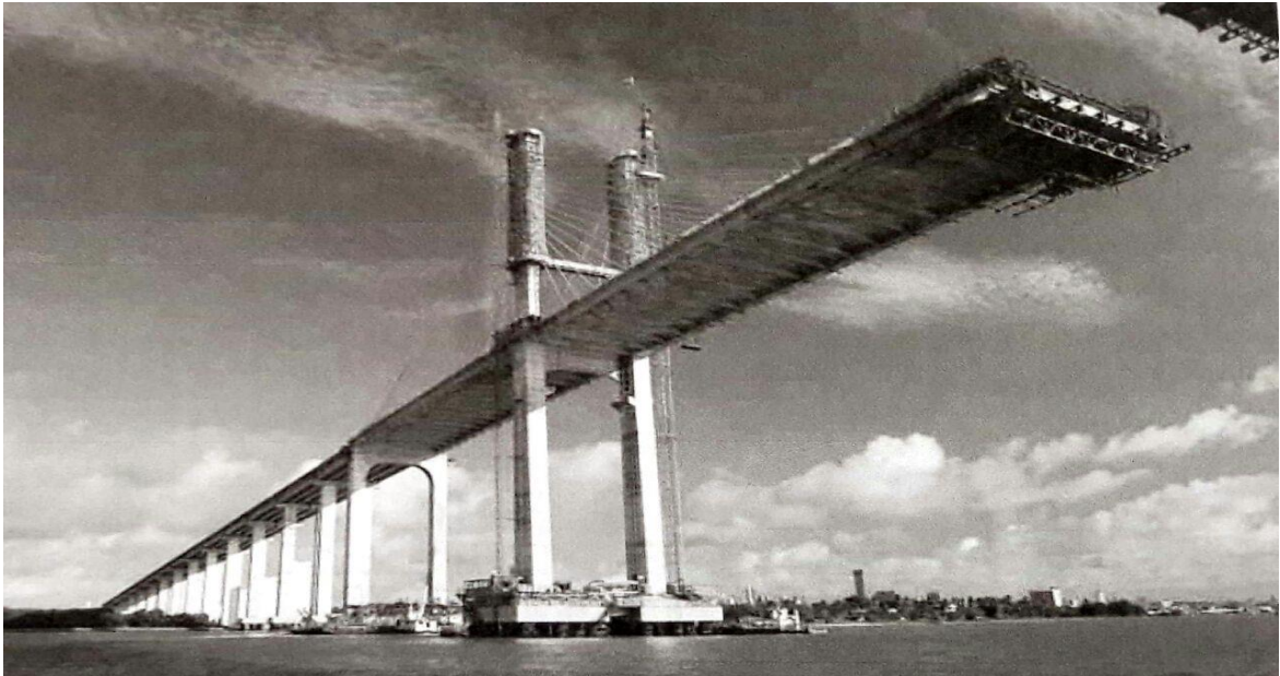
Figura 45 – Construção da Ponte Newton Navarro
