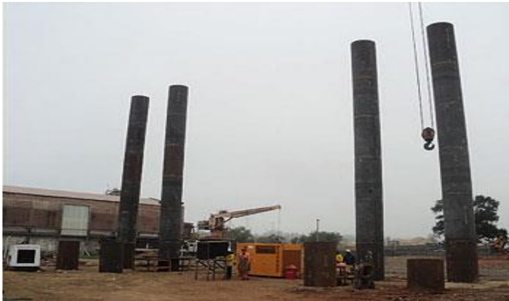
Figura 29 – Instalação de pilares para ponte Estaiada
