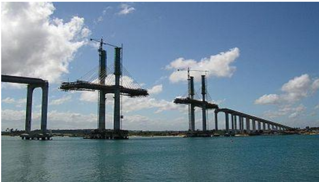
Figura 40 – Execução das obras na Ponte Newton Navarro
