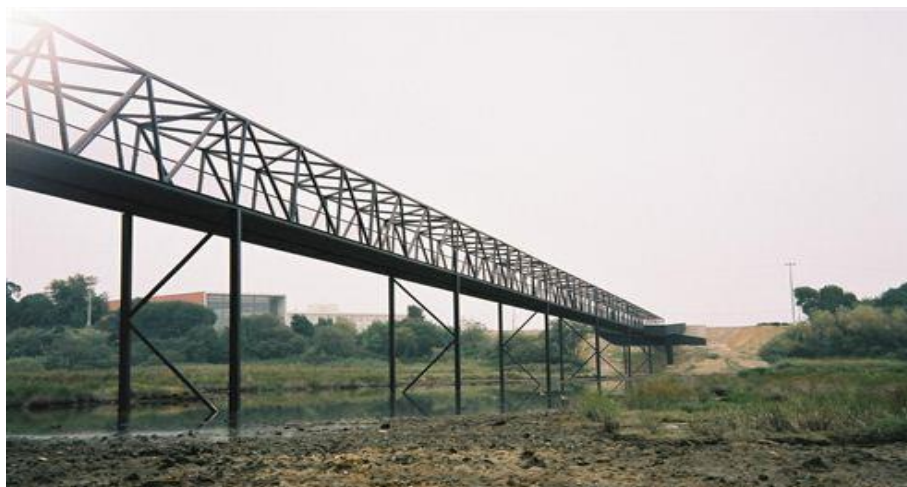
Figura 23 – Ponte em Treliças
