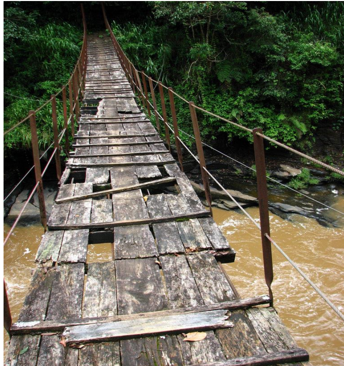
Figura 02 – Ponte para peões sobre o rio Kotmalae, Sri Lanka
