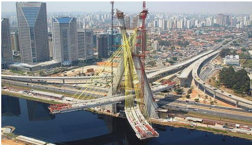
Figura 21 – Construção da Ponte Octávio Frias, São Paulo (Brasil)
