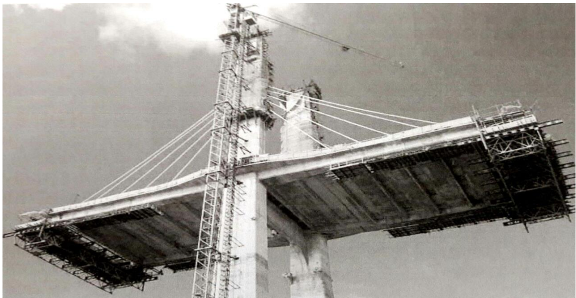
Figura 44 – Construção da Ponte com balanços sucessivos
