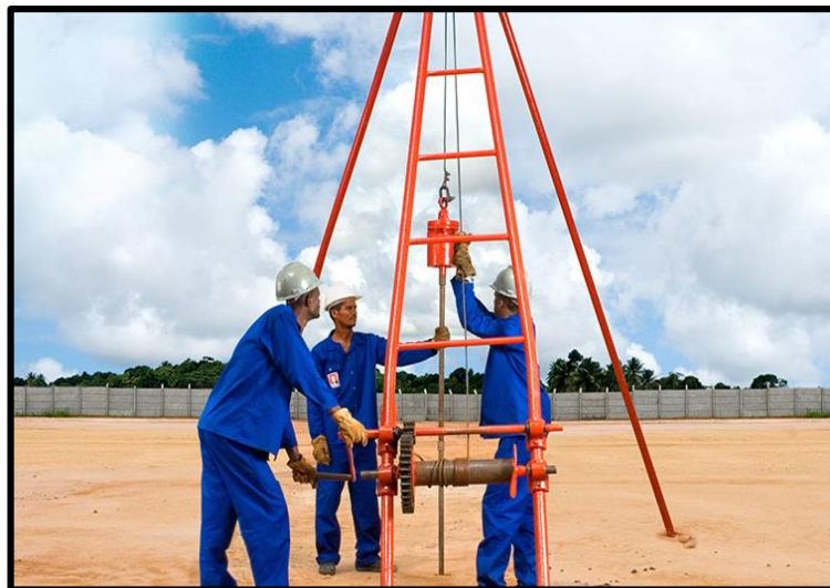
Figura 20 - Execução do ensaio SPT
