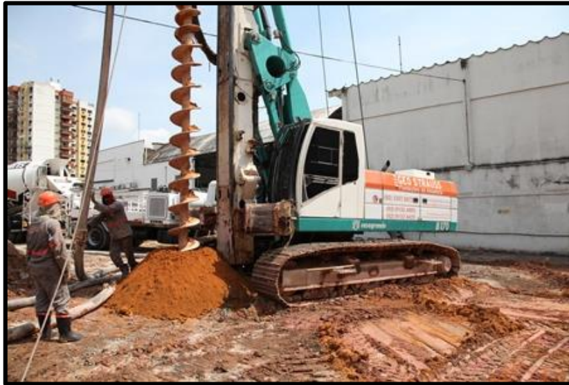
Figura 16 - Escavada mecanicamente - 01
