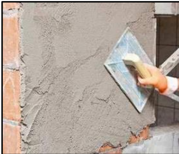
Figura 36 – Argamassa sendo aplicada
