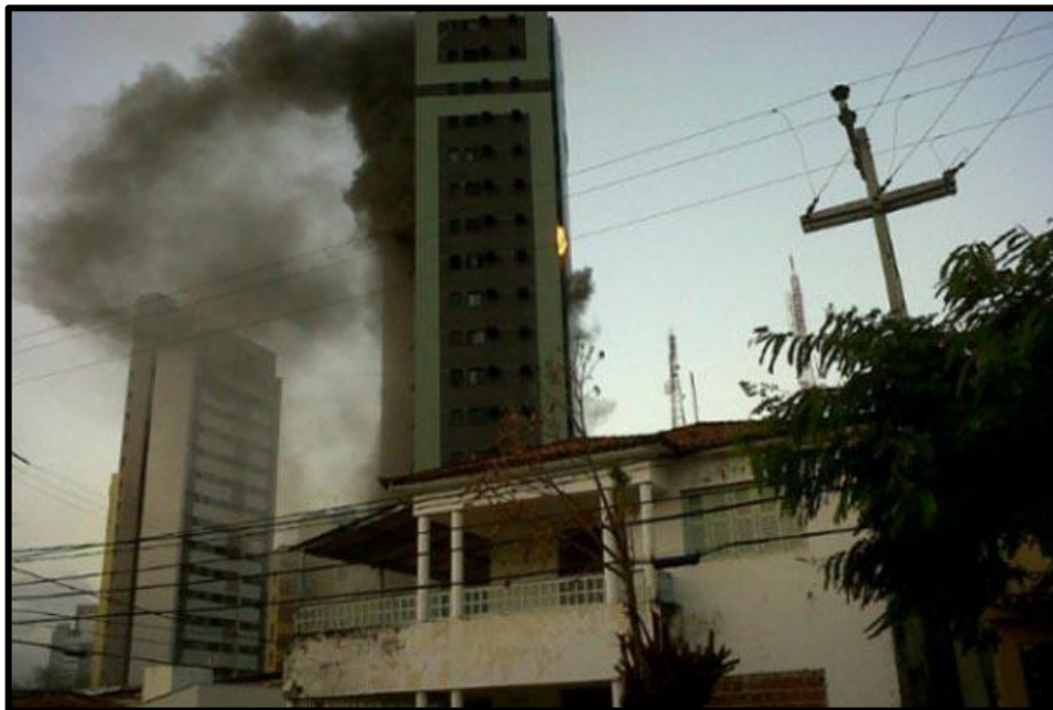
Figura 17 – Incêndio em prédio no Tirol em Natal, RN
