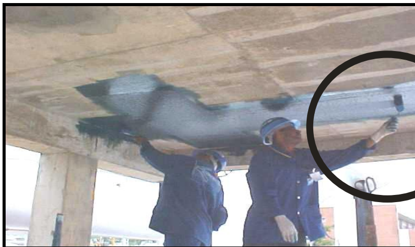
Figura 12 – Aplicação da resina epóxi estruturante em reforço estrutural da laje
