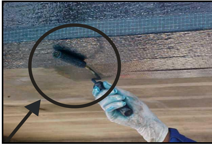
Figura 10 – Aplicação do primer epoxídico em reforço estrutural da laje
