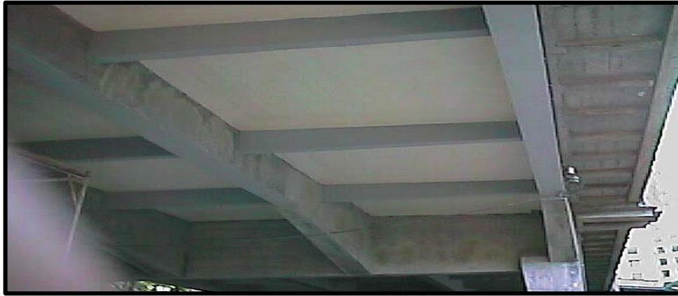
Figura 13 – Revestimento protetor em reforço estrutural de vigas de uma ponte
