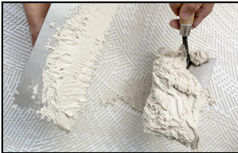
Figura 37 – Gesso sendo aplicado
