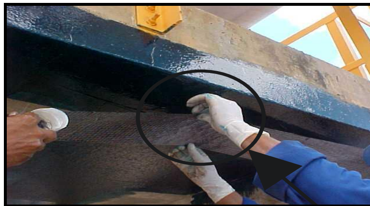
Figura 15 – Aplicação de reforço estrutural através de manta de fibra de carbono em viga
