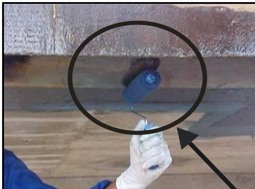
Figura 11 – Aplicação do regularizador de superfície em reforço estrutural de viga
