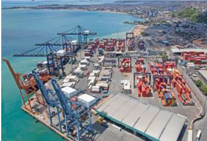
Figura 4 – Vista superior do Tecon Rio Grande
