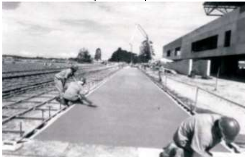
Figura 5 – Detalhe da construção do aeroporto Afonso Pena, Curitiba – PR
