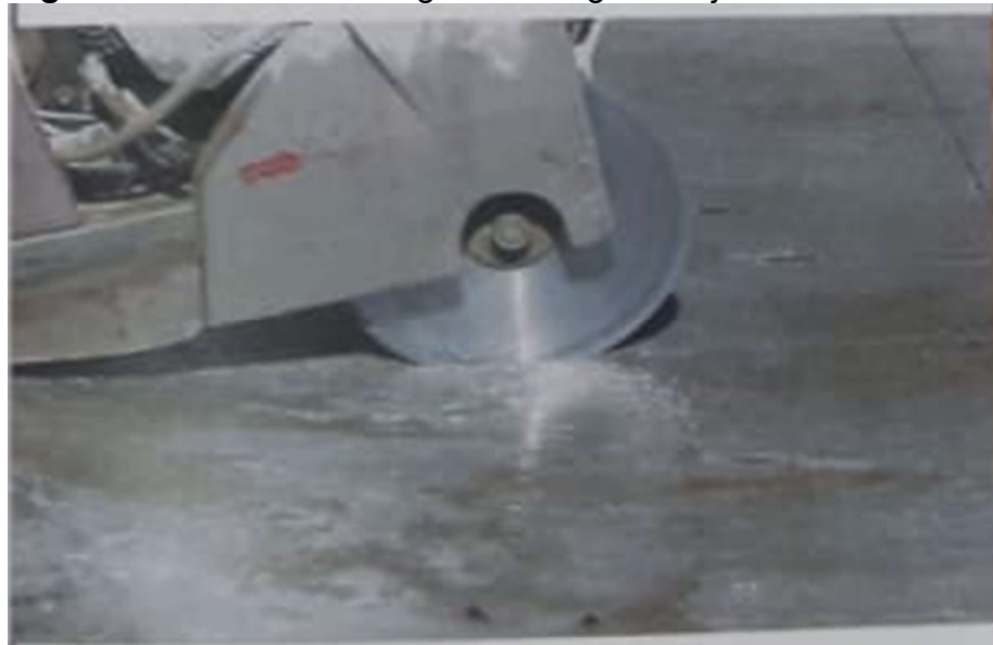
Figura 36 – Vista da serragem e selagem de juntas
