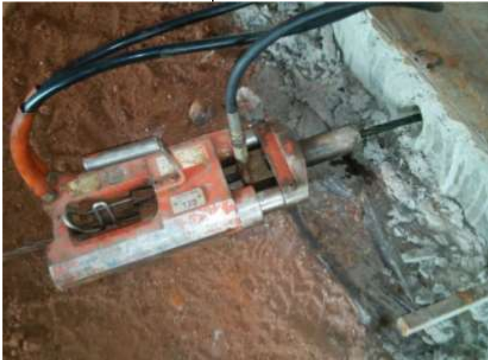
Figura 29 – Detalhamento do macaco hidráulico sendo posicionado para começar a protensão
