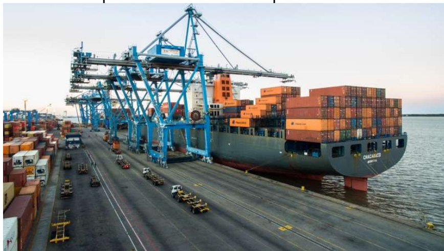
Figura 3 - Pátio do Tecon de Rio Grande – RS, construído todo em pavimento de concreto protendido
