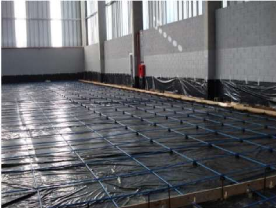
Figura 24 – Detalhe da preparação das armaduras ativas sobre a camada de deslizamento
