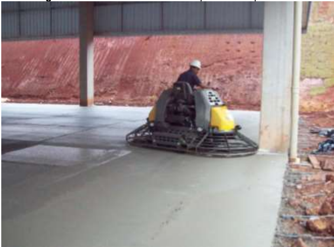
Figura 28 – Vista do acabamento superficial em pavimento
