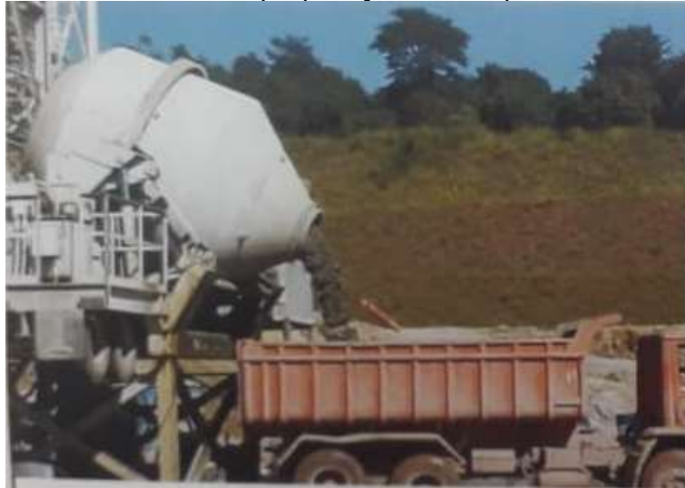
Figura 31 – Detalhe da preparação e transporte do CCP
