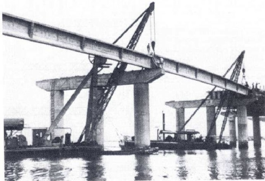
Figura 9 - Primeira obra de concreto protendido. Ponte do Galeão-Rio de Janeiro 1948.
