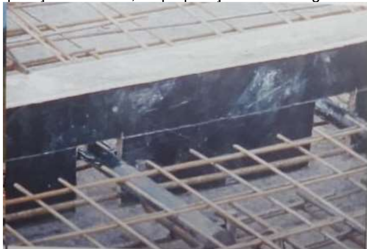
Figura 32 – Vista da preparação das formas laterais, ou preparação de trilhos, ou preparação de linhas-guia
