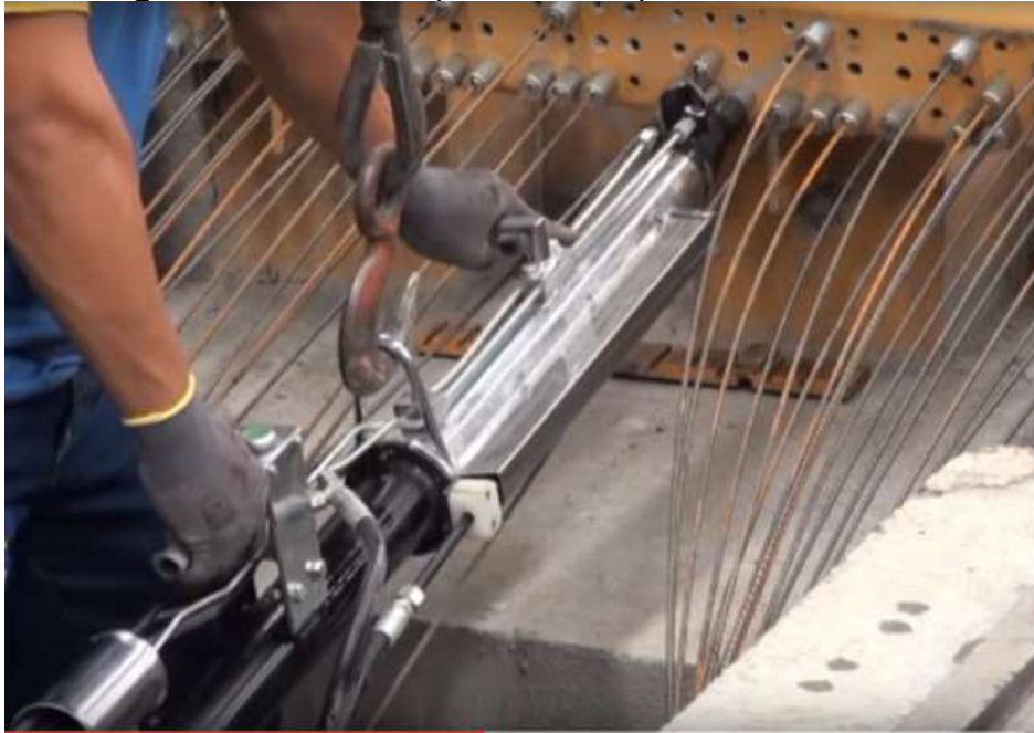
Figura 12 – Vista do processo de protensão de cabos
