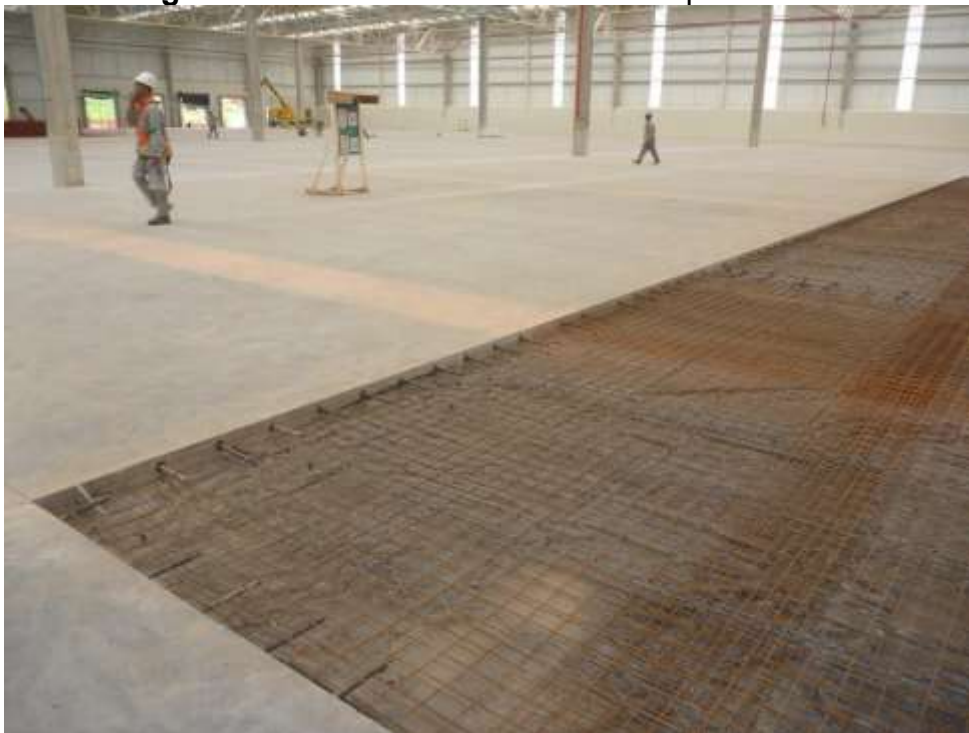
Figura 19 Detalhe das armaduras dos pavimentos
