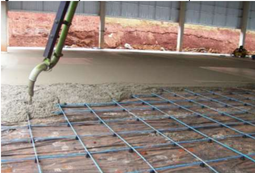
Figura 26 – Vista do lançamento do caminhão bomba espalhando o concreto
