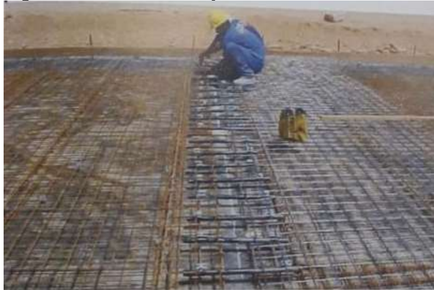
Figura 33 – Vista da colocação de BT, BL e armaduras
