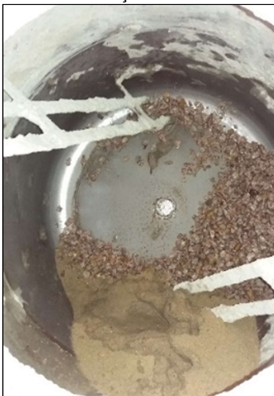
Figura 40 - Detalhe da adição de areia na mistura.
