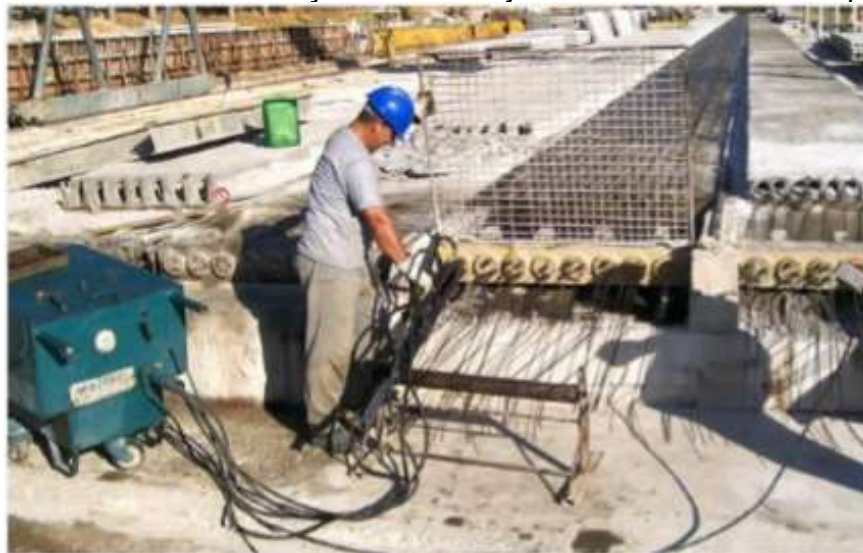
Figura 11 – Detalhe da execução de uma laje alveolar em concreto protendido
