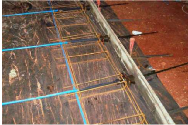
Figura 25 – Detalhamento das armaduras de reforço de borda e fretagem
