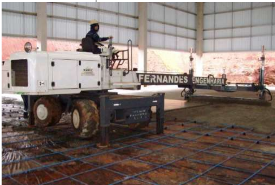
Figura 27 - Detalhe do adensamento e nivelamento do concreto por meio de plataforma laser screed
