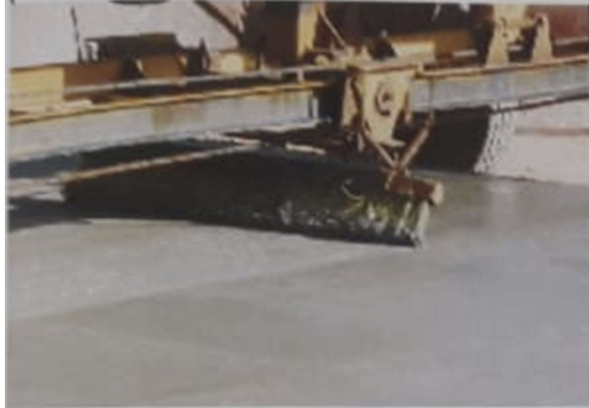
Figura 35 – Vista do desempenamento e texturização do CCP
