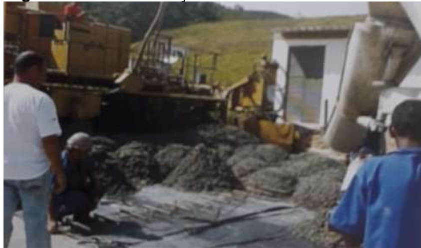
Figura 34 – Vista do lançamento e adensamento do CCP.
