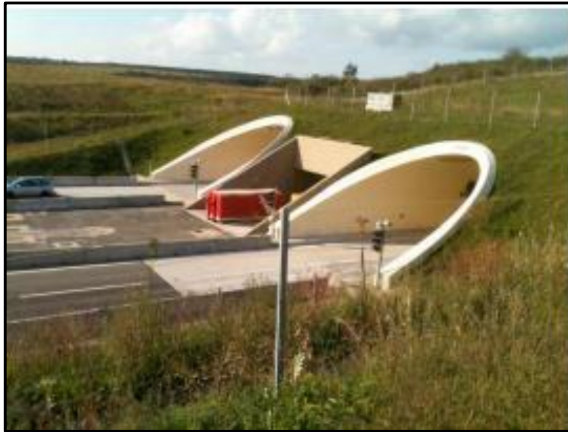
Figura 4 - Conjunto de túneis com passagem superior cercada.
