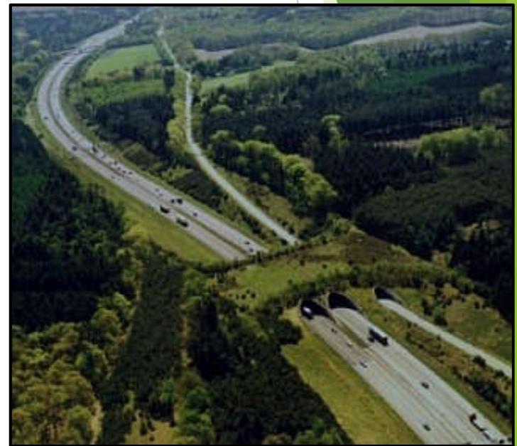
Figura 13: Rampas construídas para a passagem de animais.
