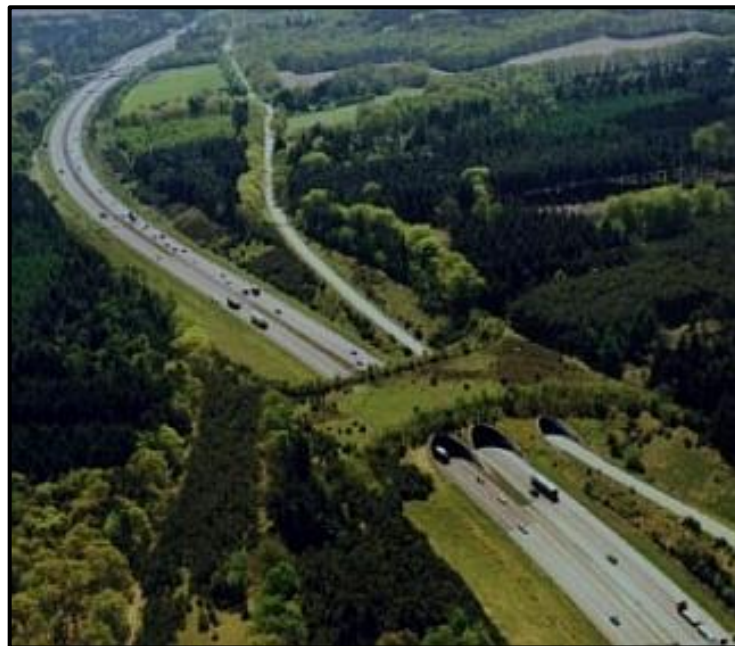
Figura 7 - Rampa construída para a passagem de animais.
