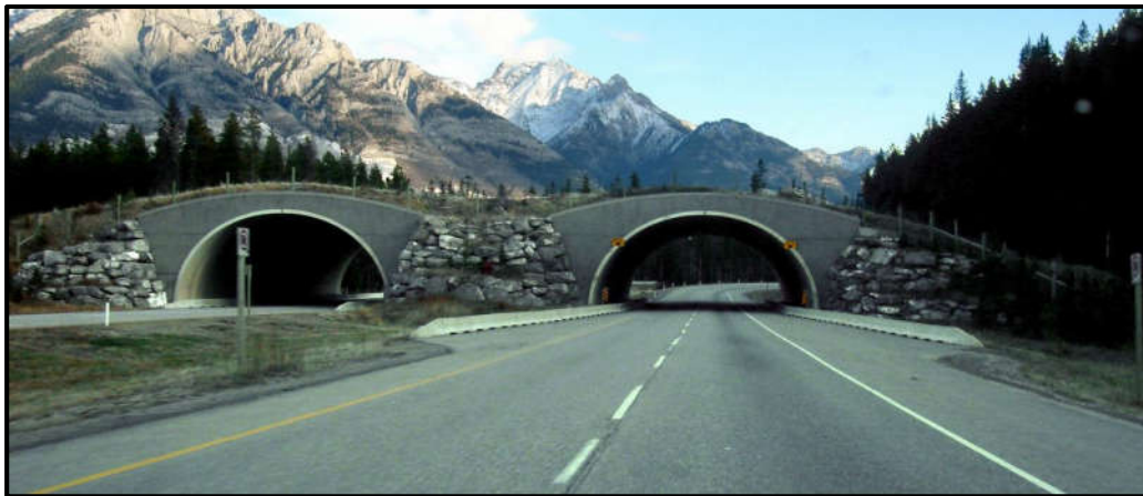
Figura 12: Rampas construídas para a passagem de animais
