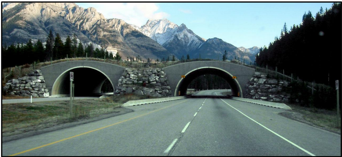
Figura 6 - Rampas construídas para a passagem de animais.
