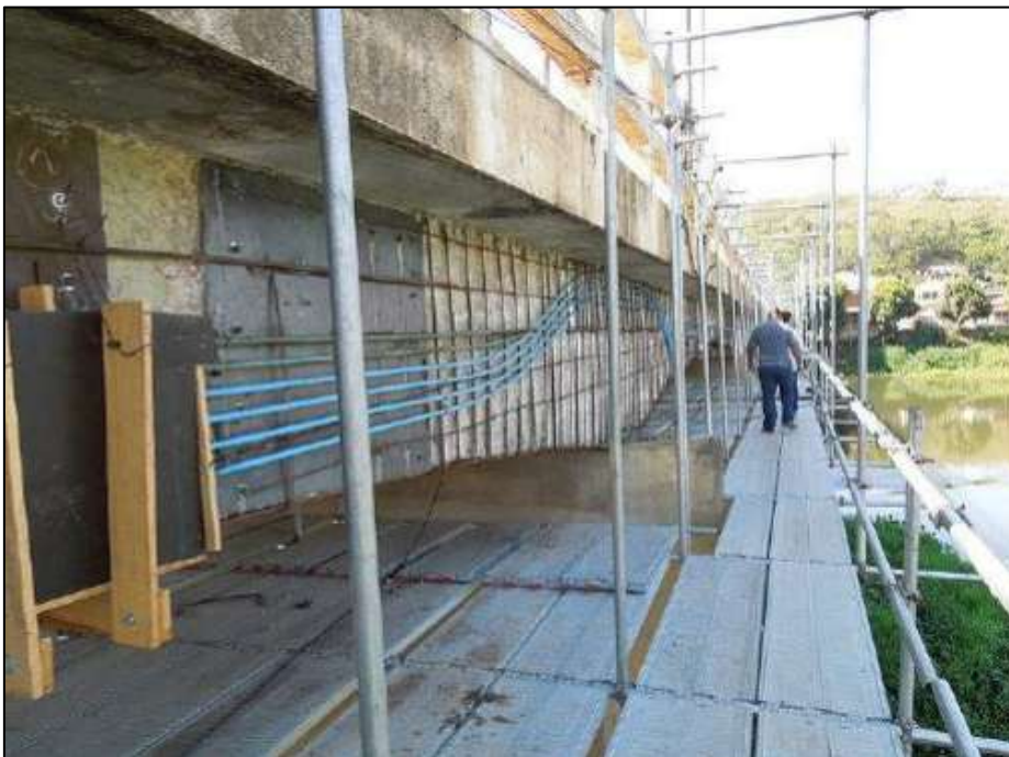
Figura 22 - Protensão externa.
