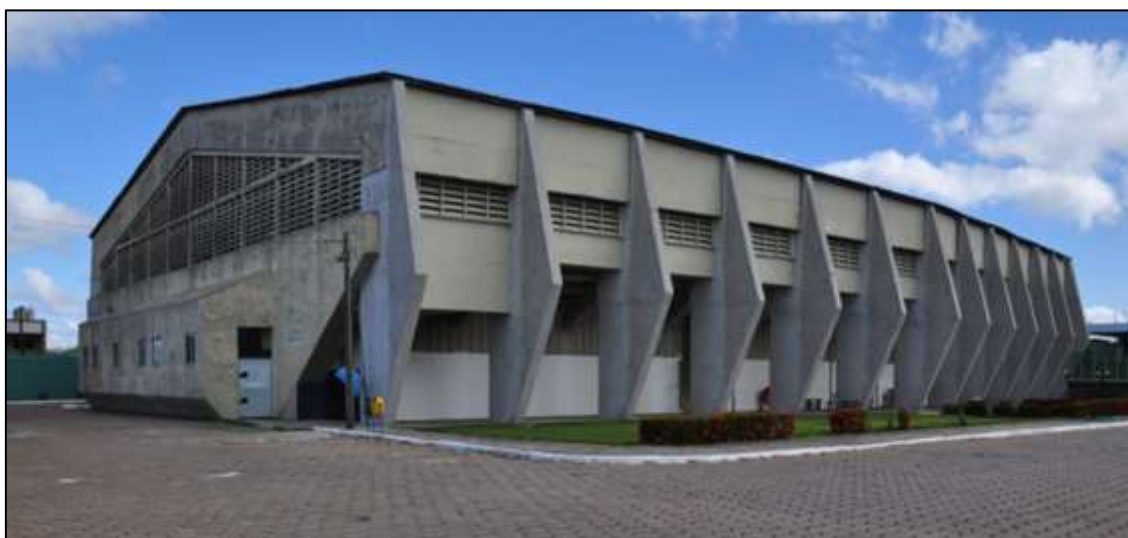
Figura 34 – Perspectiva externa do ginásio SESI-SENAI mostra viga apoiada no pilar.
