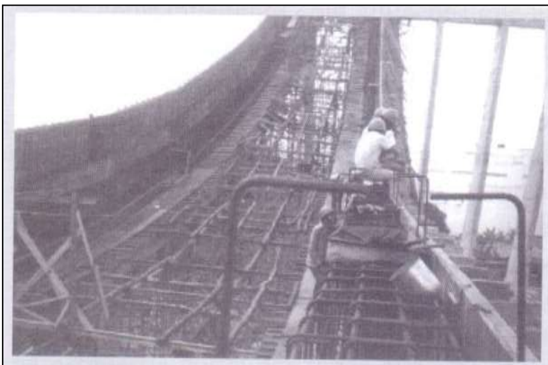
Figura 31 – Complexidade da montagem das formas e armações da viga protendida da Catedral de Natal/RN.
