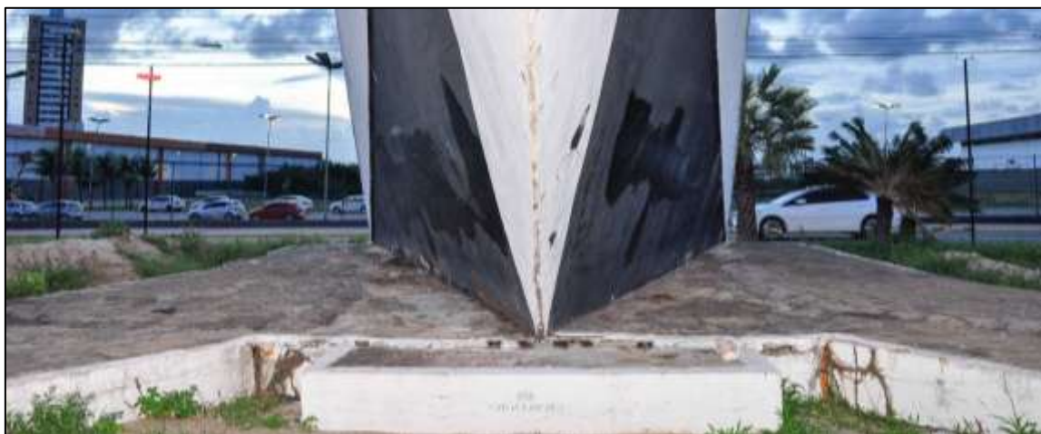
Figura 44 – Bloco de fundação do Pórtico Monumental de Natal/RN.
