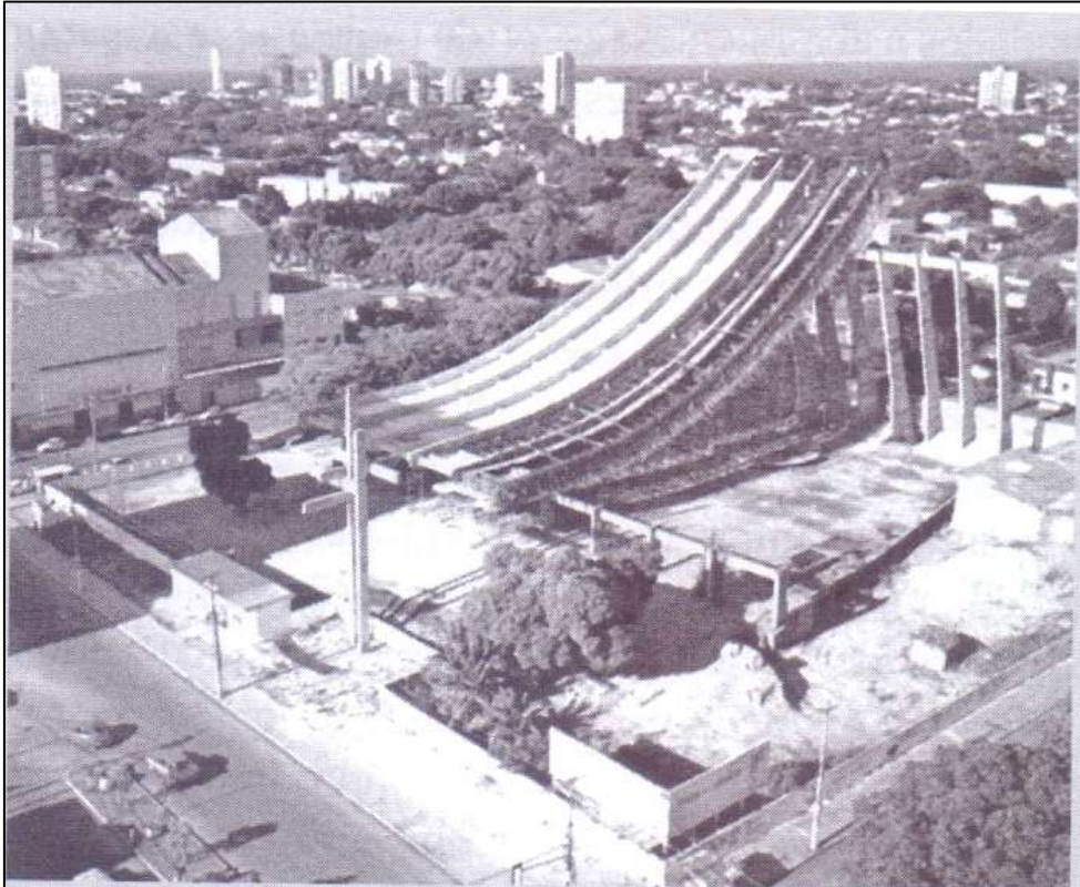
Figura 30 – Vista geral da fase final da construção da Catedral de Natal/RN.
