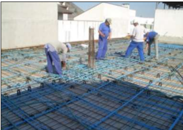
Figura 18: Viga pós-tensionada, cabos não aderentes.
