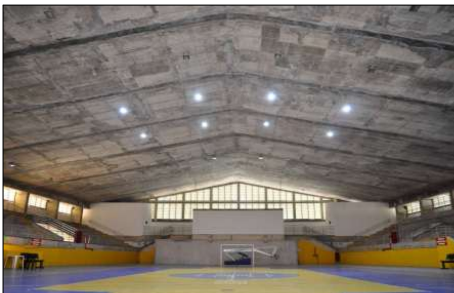
Figura 32 – Vigas protendidas e lajes em concreto armado do telhado do ginásio SESI-SENAI.
