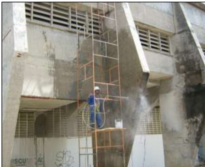
Figura 41 – Aplicação do hidrojateamento para remoção das sujeitas e resultado final.
