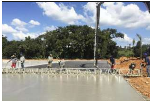
Figura 14 – Concreto para pavimento.
