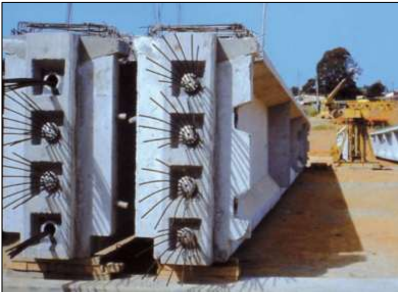
Figura 17: Viga pós-tensionada, cordoalhas de cabos aderentes.
