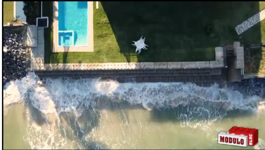
Figura 25 - Vista aérea - blocos inseridos, com o avanço das ondas.
