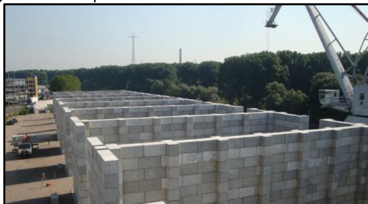
Figura 19 – Galpões construídos com blocos. Vista lateral.
