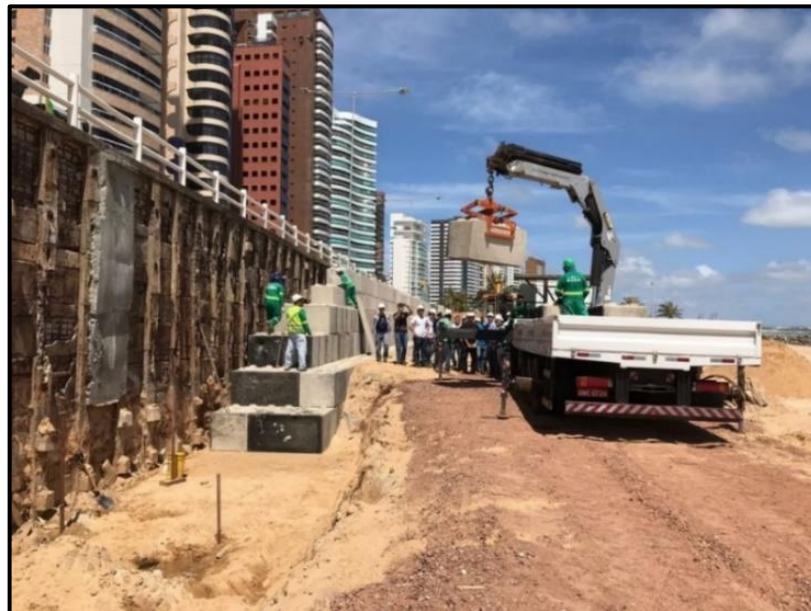
Figura 31 - Colocação dos blocos na praia de Areia Preta.
