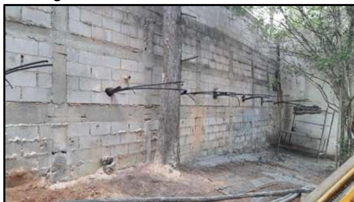
Figura 4 - Muro atirantado de alvenaria.
