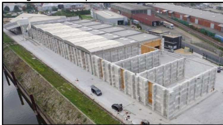
Figura 18 – Galpões construídos com blocos.
