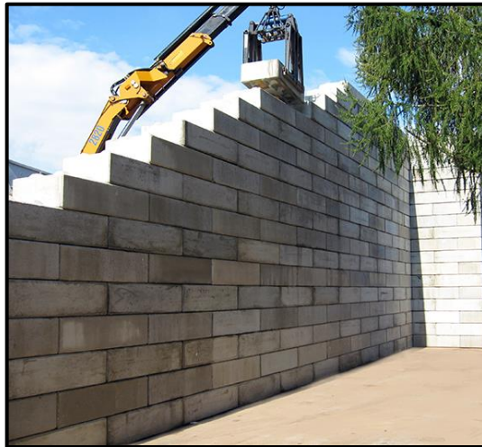
Figura 13 - Construção de muro com uso do bloco.
