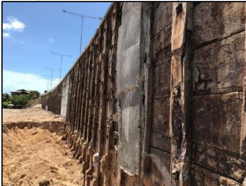
Figura 30 - Vista frontal da contenção antiga.
