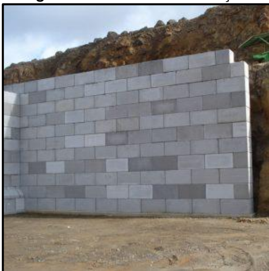
Figura 14 – Muro de contenção.
