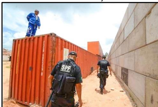
Figura 20 – Processo de finalização do muro de divisa.
