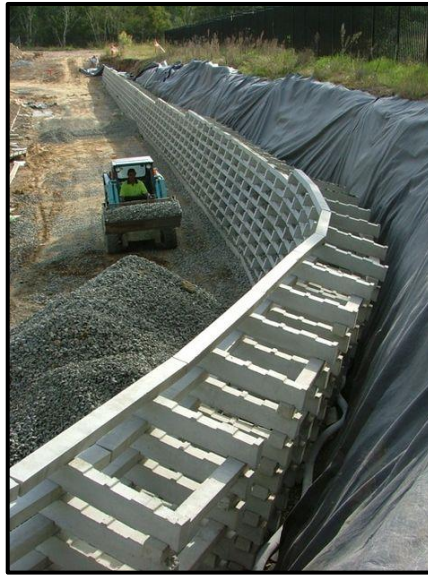
Figura 7 - Construção de muro crib wall .
