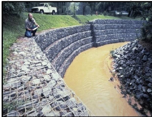
Figura 8 - Contenção utilizando gabião.
