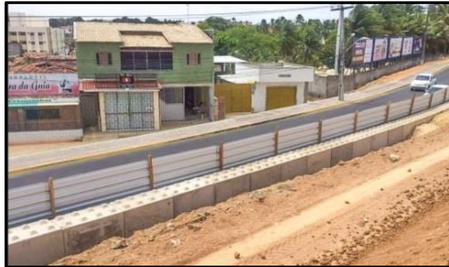
Figura 22 - Processo de finalização da barreira de contenção.
