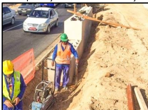
Figura 21 – Compactação do solo e colocação dos blocos.
