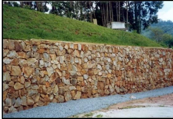
Figura 6 – Muro de gravidade executado com rocha.
