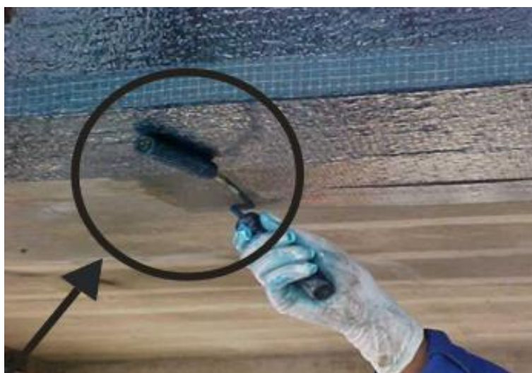
Figura 16 – Imprimação da superfície de uma laje em reforço estrutural executado pela empresa Engecal.
