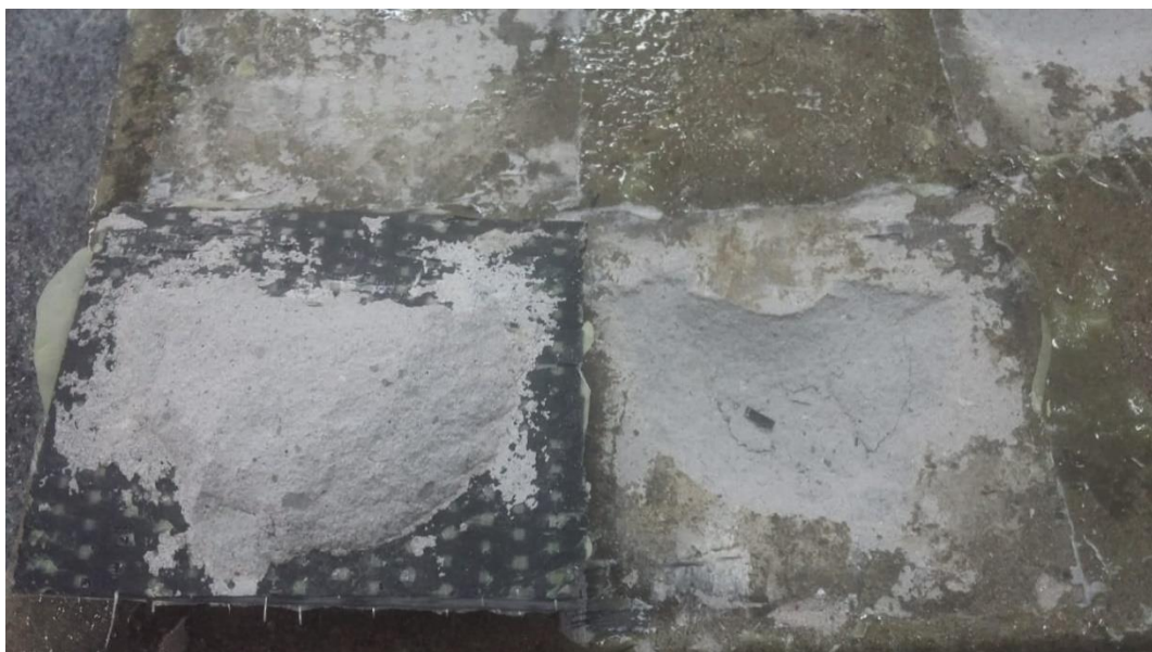
Figura 57 – Aspectos da superfície da lâmina L2 e do substrato da placa de concreto 04 pós-ensaio.
