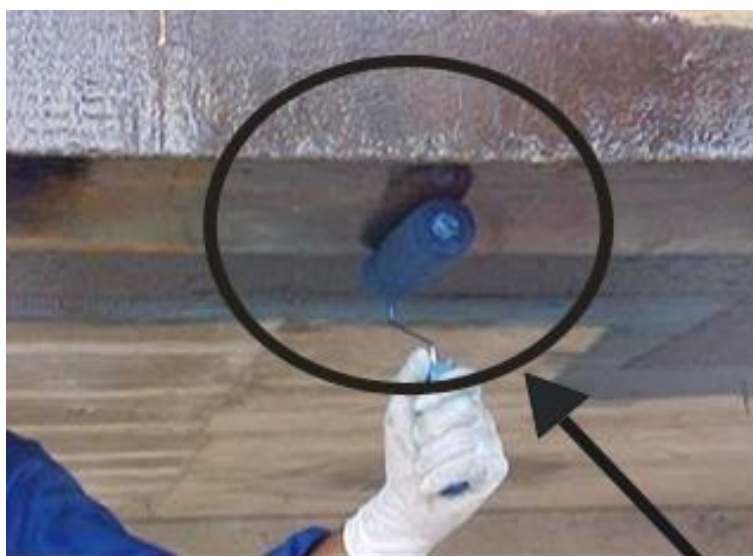
Figura 17 – Aplicação do regularizador de superfície em uma viga numa das etapas do reforço estrutural executado pela empresa Engecal.
