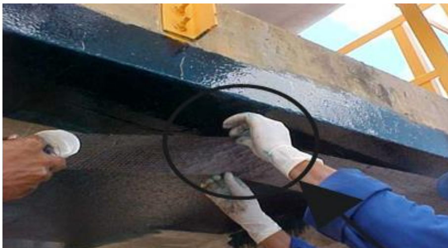
Figura 19 – Aplicação da lâmina da fibra em um reforço estrutural executado pela empresa Engecal.
