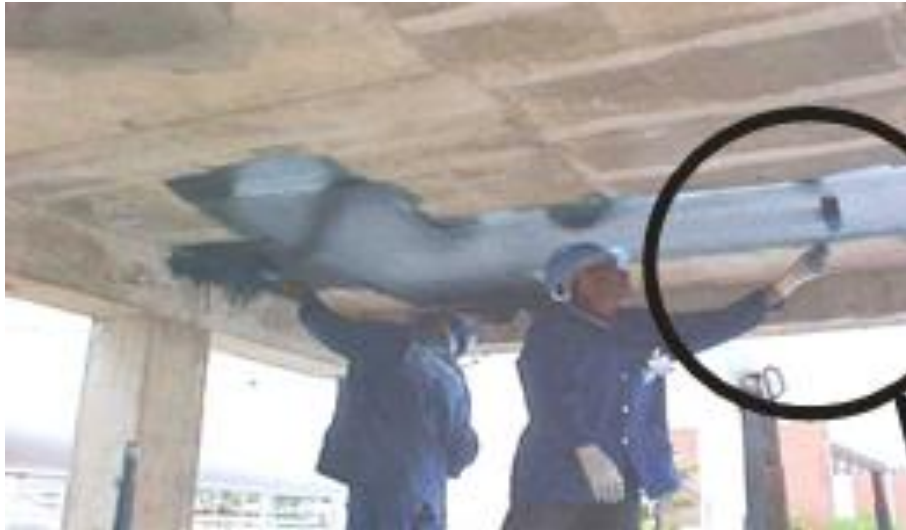
Figura 18 – Aplicação de epóxi estruturante em laje. Reforço estrutural à flexão executado pela empresa Engecal.
