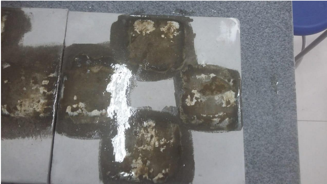
Figura 26 – Detalhe da placa após a aplicação do primer epóxi.
