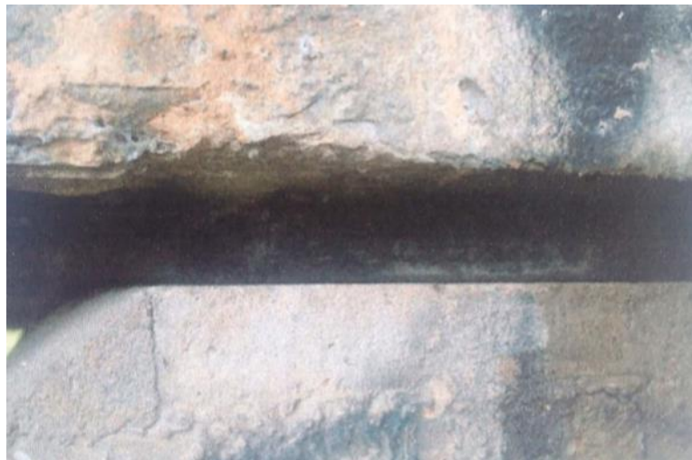
Figura 63 – Detalhe do aparelho de apoio da segunda ponte de Igapó (1988)
