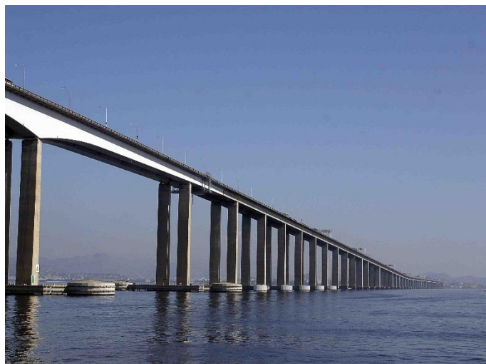
Figura 29 – Vista de ponte em viga
