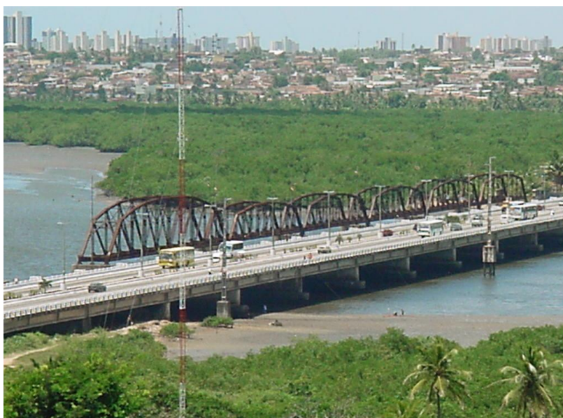
Figura 55 – Vista da ponte Presidente Costa e Silva – Natal/RN
