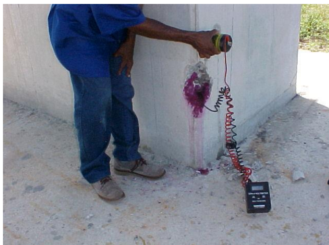
Figura 57 – Vista do ensaio de probabilidade de corrosão em pilar de concreto armado de ponte rodoviária
