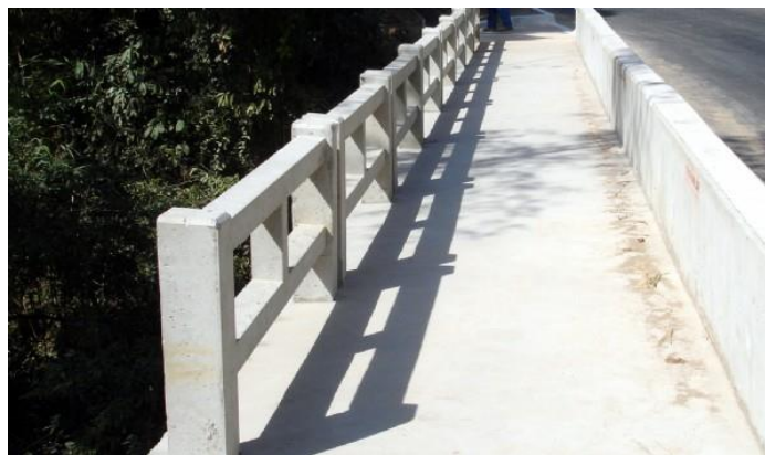
Figura 9 – Vista de Passeio, barreira de proteção e guarda-corpos de uma ponte
