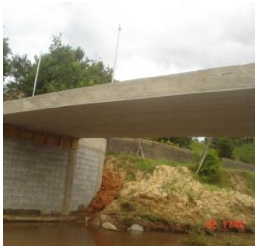
Figura 24 – Detalhe de ponte em laje
