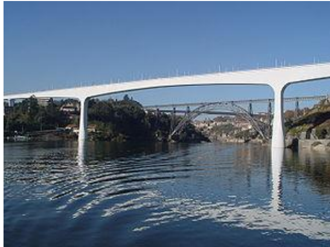
Figura 32 – Vista da ponte ferroviária São João – Portugal
