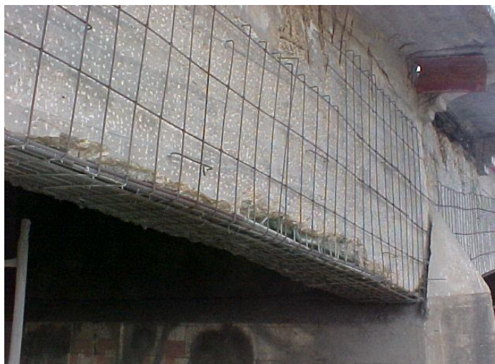
Figura 51 – Vista do reforço com adição de armadura (encamisamento) na ponte Jerônimo Rosado – Mossoró/RN
