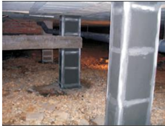
Figura 49 – Vista de pilar confinado por lâminas de fibra de carbono
