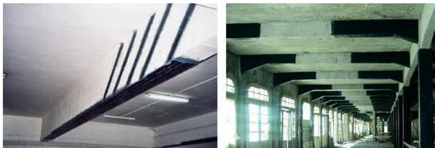
Figura 50 – Detalhe de vigas reforçadas ao cortante, por lâminas de fibra de carbono
