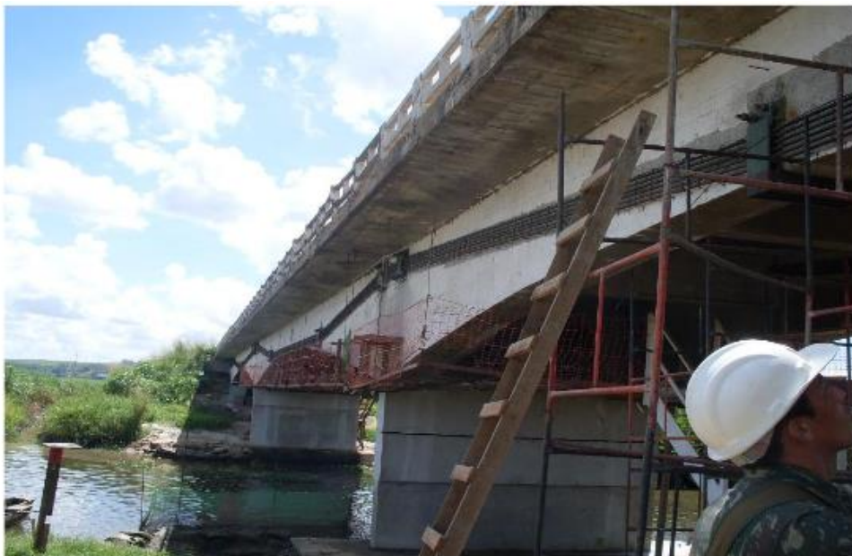
Figura 54 – Vista da facilidade de inspeção visual do sistema protendido externamente
