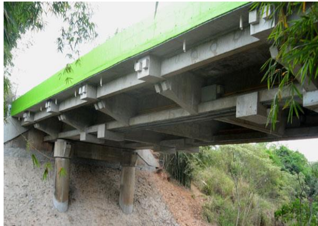
Figura 7 – Vista de laje e vigamento de tabuleiro.
