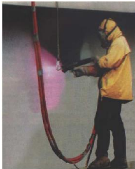
Figura 46 – Aplicação de película de ZTP
