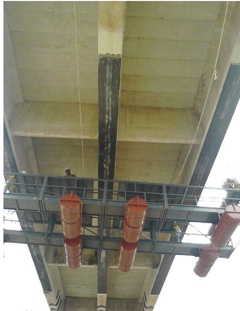
Figura 47 – Detalhe do reforço com fibra de carbono na ponte Teles Pires – MT.
