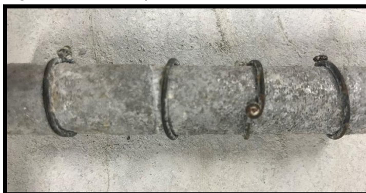
Figura 35 – Envelopamento Galvânico de Alumínio
