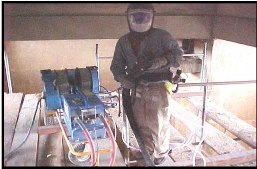
Figura 23 – Vista do equipamento para aplicação da técnica de ZTP
