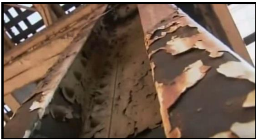
Figura 3 – Corrosão eletroquímica em estruturas metálicas.
