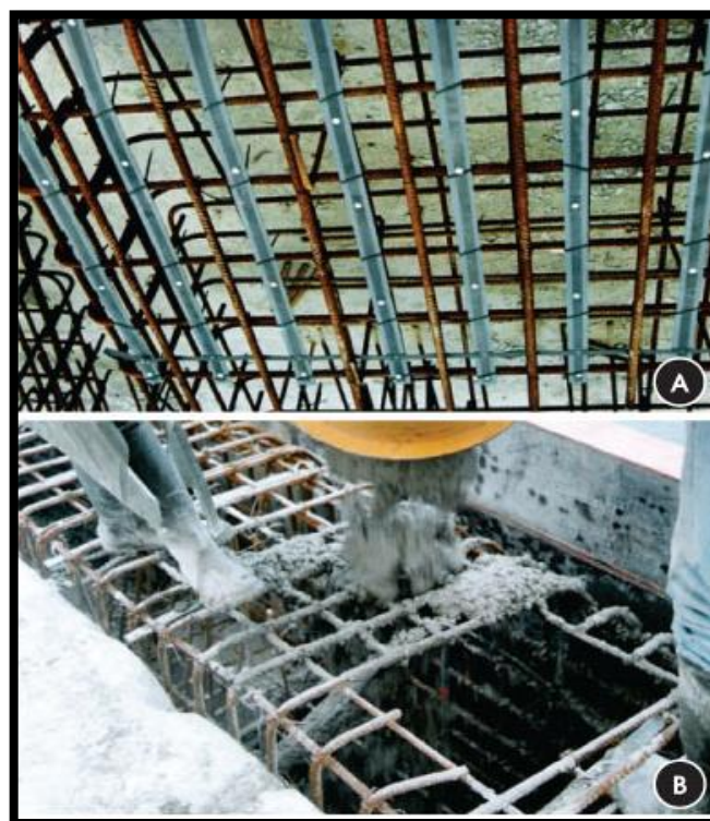
Figura 21 – Instalação das fitas e concretagem.
