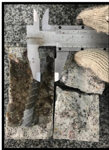
Figura 29 – Amostra de concreto sem o envelopamento de alumínio.
