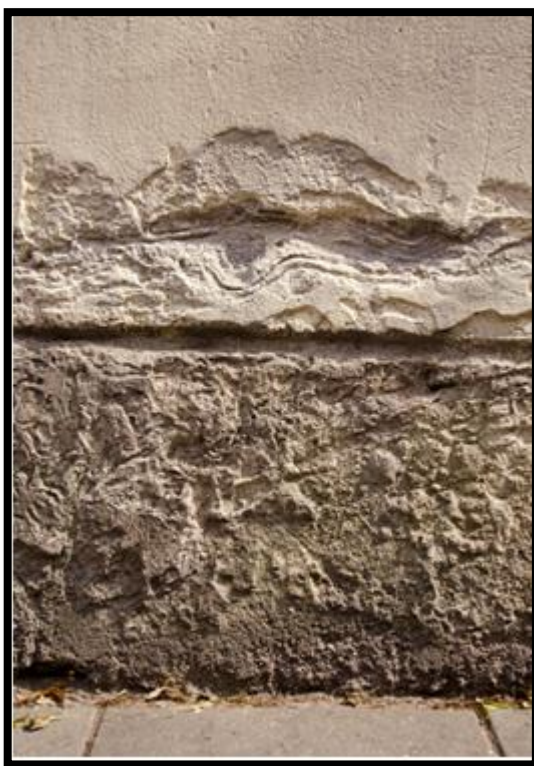
Figura 4 – Corrosão química.
