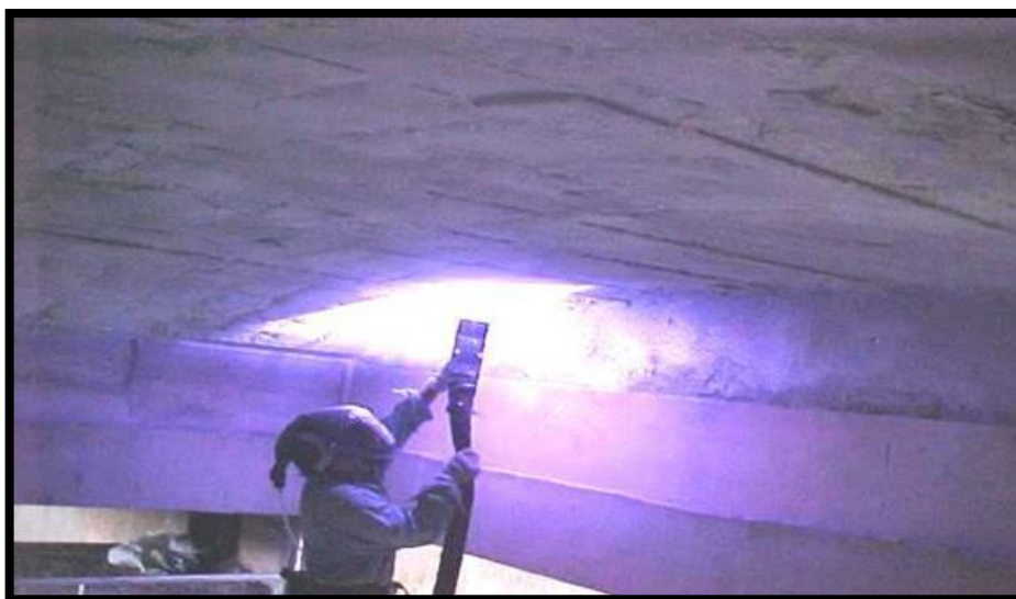
Figura 22 – Aplicação da técnica de ZTP no reservatório de água da CAERN
