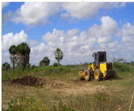
Figura 12 – Retroescavadeira extraindo argila da natureza
