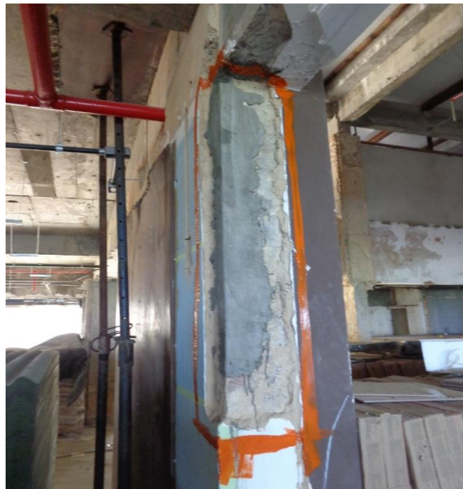
Figura 63 – Serviço de recuperação finalizado e sinalizado para fiscalização
