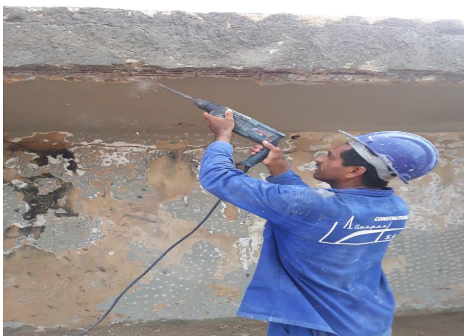
Figura 59 – Retirada de concreto envolvente das armaduras em estado de corrosão
