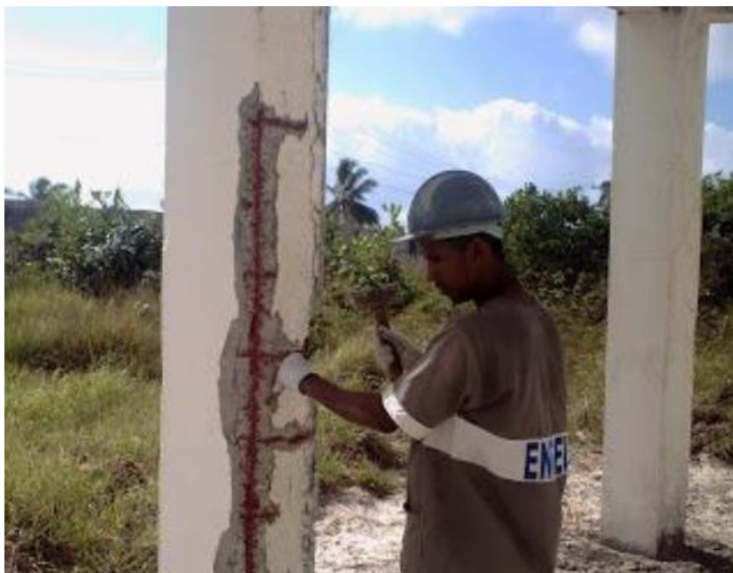
Figura 41 – Apicoamento manual da superfície de concreto
