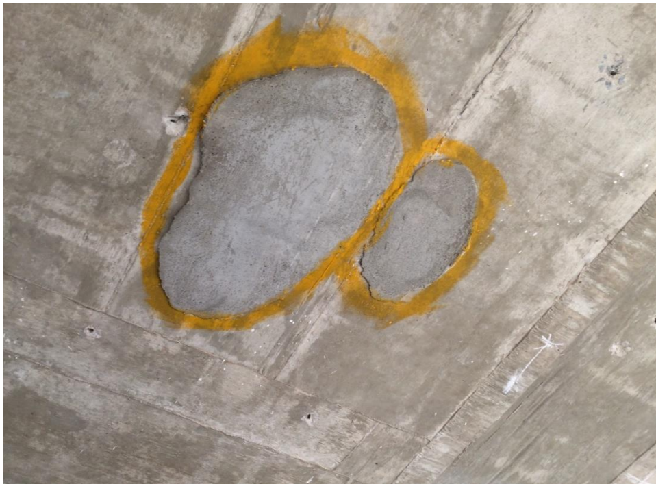
Figura 65 – Serviço de recuperação finalizado em laje, sinalizado aguardando a fiscalização
