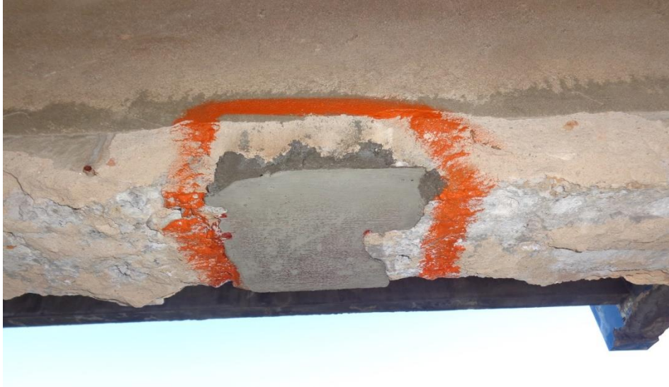
Figura 64 – Serviço de recuperação finalizado em viga, sinalizado para fiscalização
