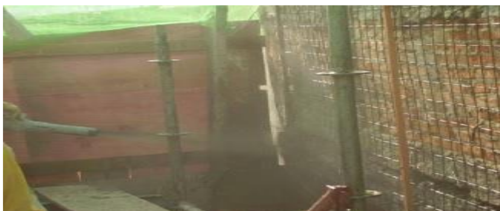
Figura 50 – Execução da projeção de concreto
