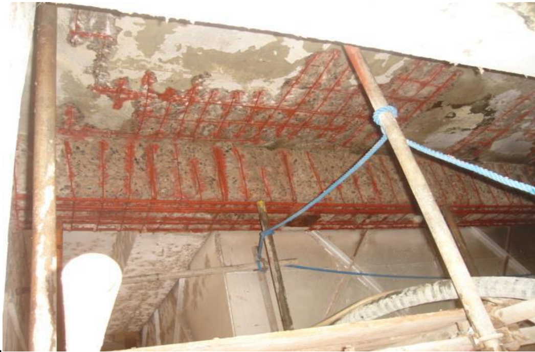
Figura 60 – Aplicação de pintura a base de zinco
