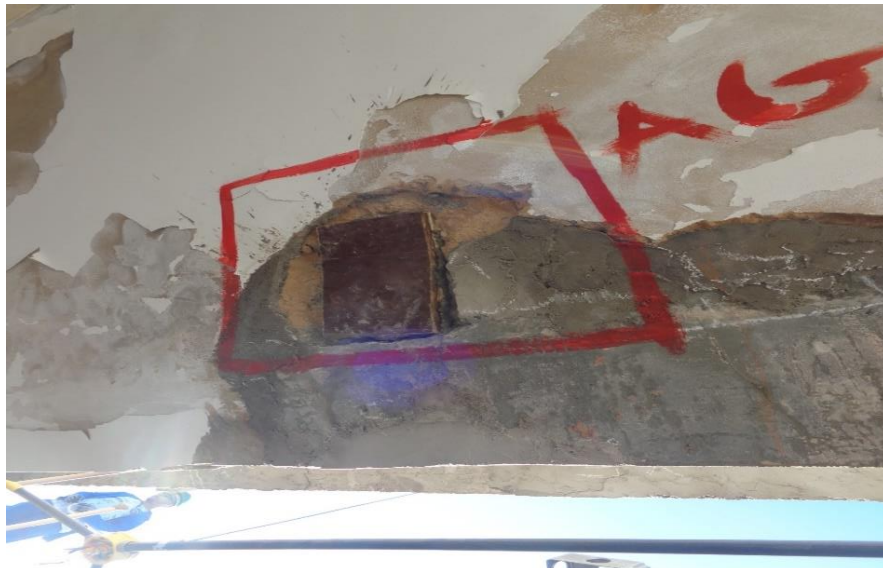
Figura 61 – forma de madeira para encamisamento de viga de concreto
