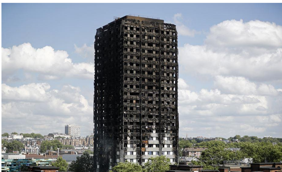
Figura 16 – Ação destruidora do fogo em edifício de concreto armado
