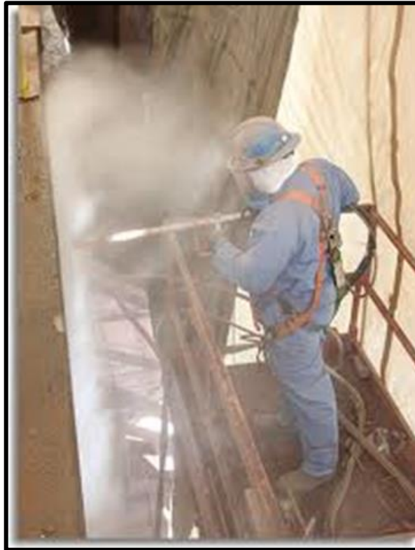
Figura 36 – Jato de areia – Hidrojateamento
