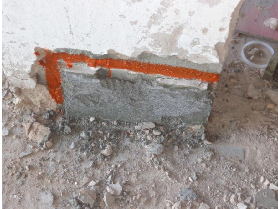
Figura 62 – Serviço de recuperação finalizado e sinalizado para fiscalização
