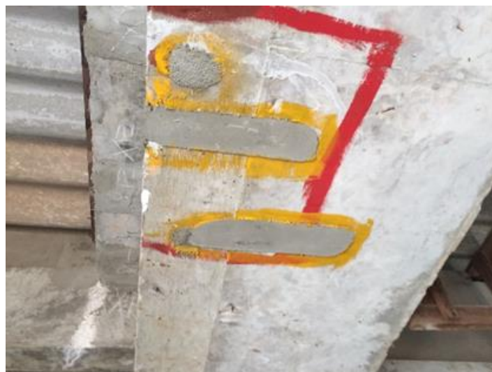
Figura 46 – Recuperação de laje com graute tixotrópico
