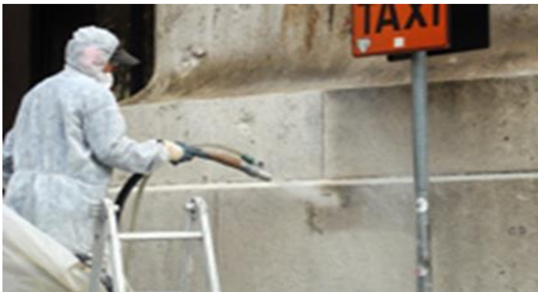
Figura 38 – Jato de limalha de aço
