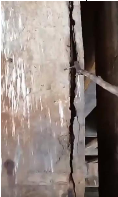
FIGURA 35 – Deslocamento do concreto e aço deteriorado.
