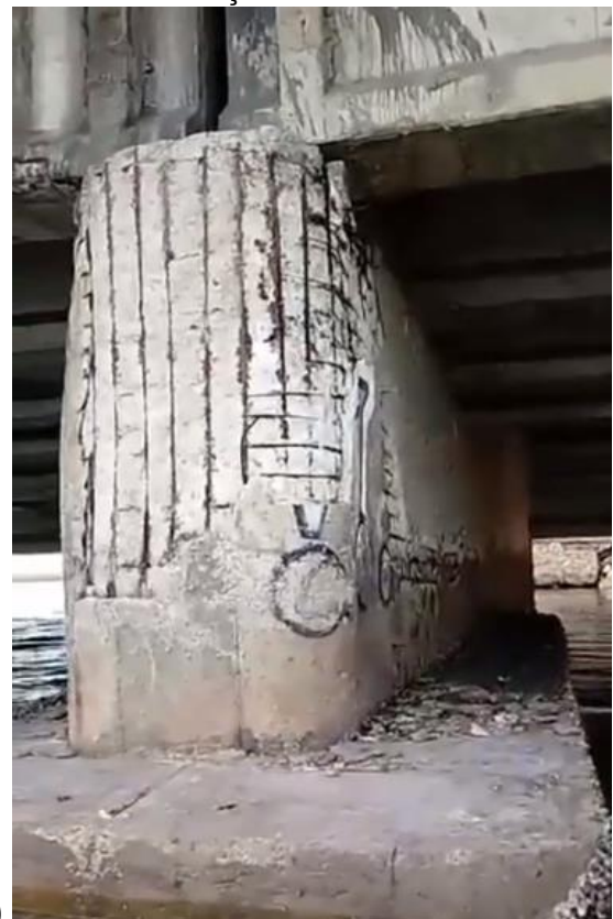
FIGURA 35 – Deslocamento do concreto e aço deteriorado.
