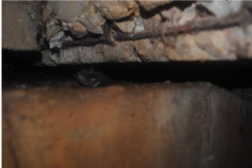
FIGURA 38 – Detalhe aparelho de apoio obra antiga.
