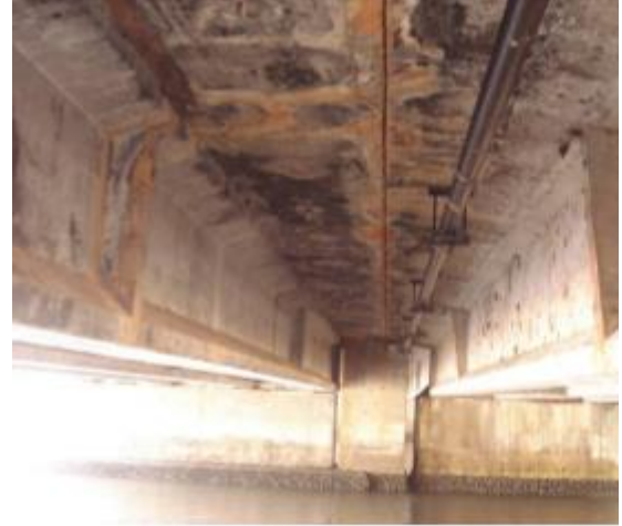
FIGURA 39 – Dreno posicionado sobre o talão inferior da viga e Junta com problemas de vedação.
