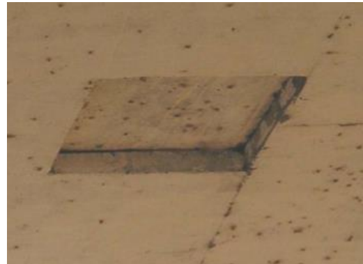
FIGURA 19 –Janela de acesso ao interior da estrutura.
