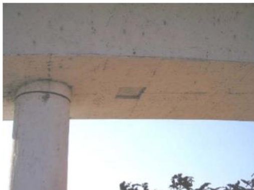
FIGURA 19 –Janela de acesso ao interior da estrutura.
