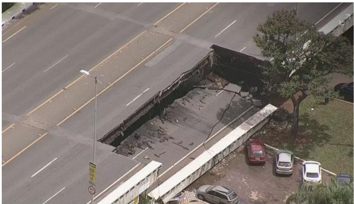
FIGURA 2 - Desabamento do viaduto eixão sul em Brasília.
