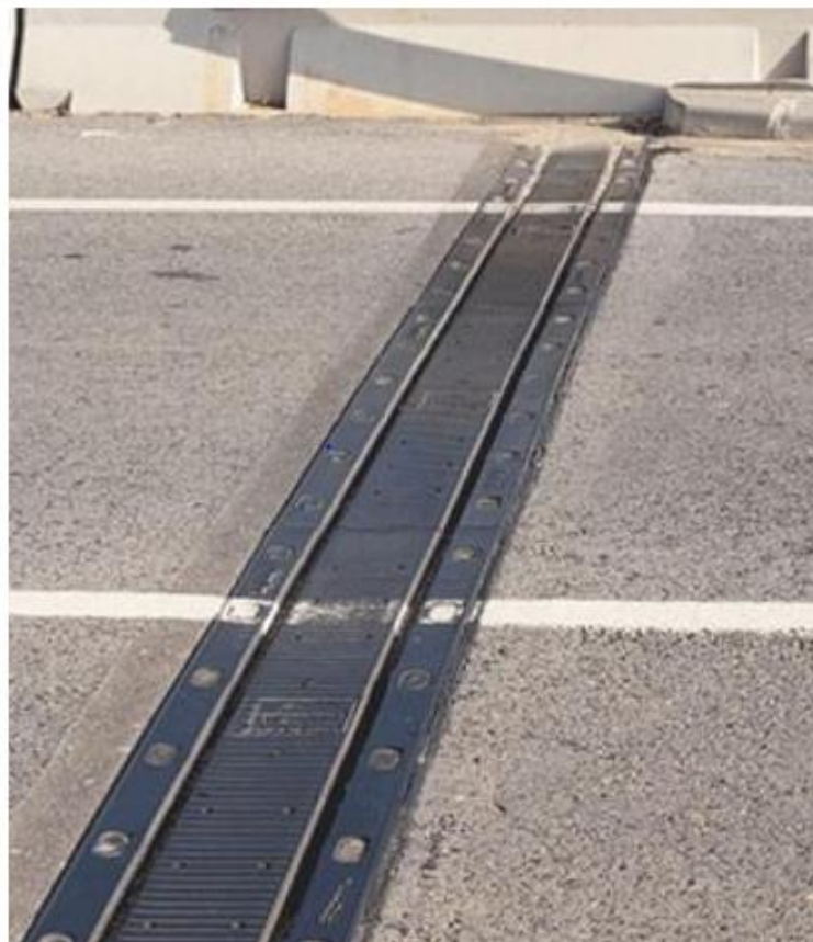
FIGURA 17 – Junta de dilatação de uma ponte.
