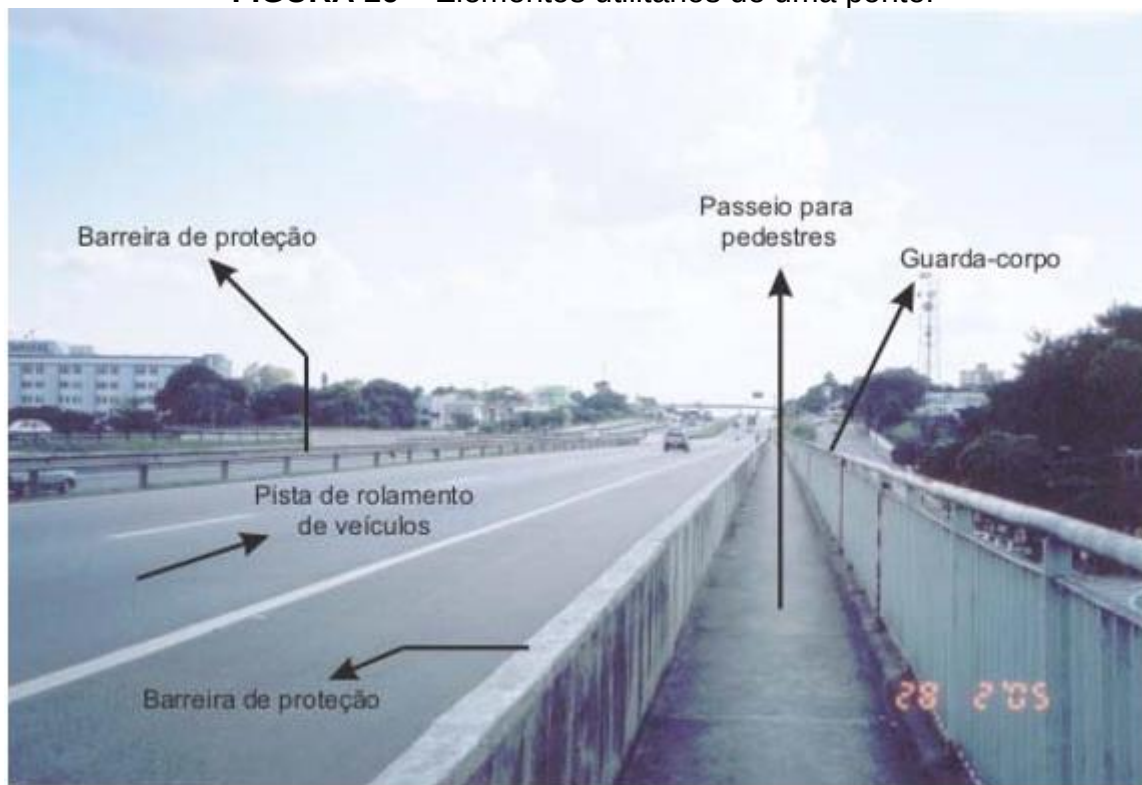
FIGURA 16 – Elementos utilitários de uma ponte.
