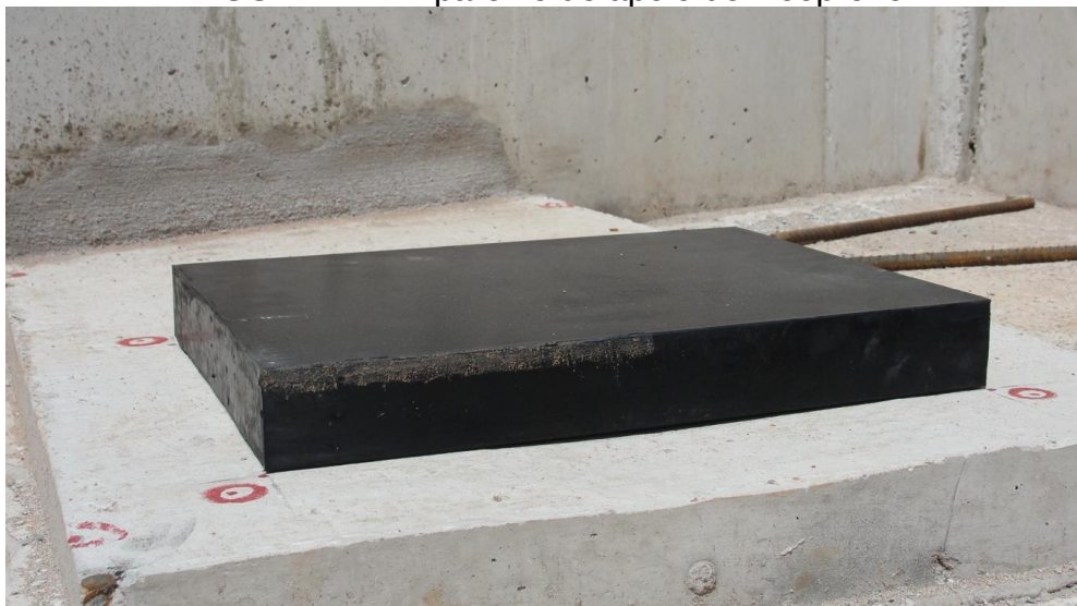
FIGURA 21 – Aparelho de apoio de Neoprene
