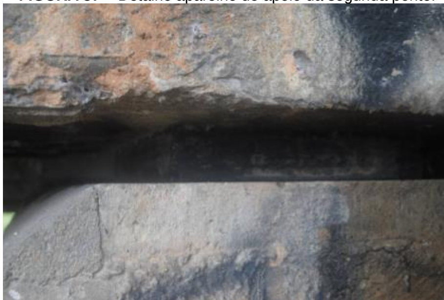
FIGURA 37 – Detalhe aparelho de apoio da segunda ponte.
