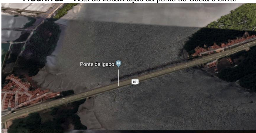
FIGURA 32 – Vista de Localização da ponte de Costa e Silva.
