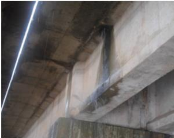
FIGURA 39 – Dreno posicionado sobre o talão inferior da viga e Junta com problemas de vedação.
