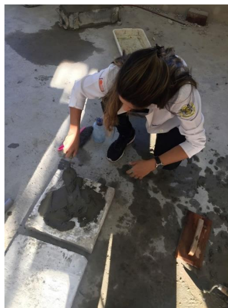
Figura 16- Processo de assentamento da argamassa
