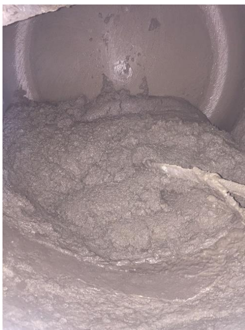
Figura 9- Argamassa pronta ainda na betoneira
