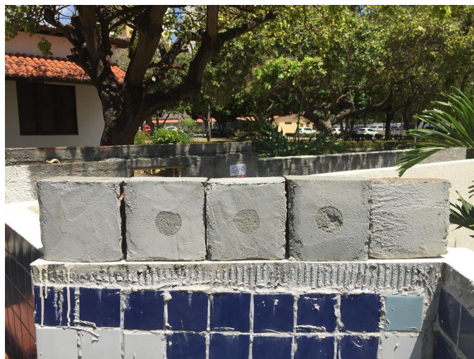
Figura 20- Argamassa exposta ao ambiente externo
