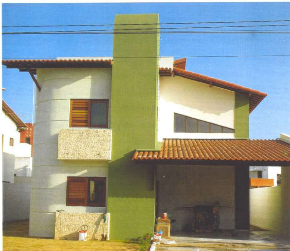
Figura 30: Foto frontal da residência depois da obra finalizada Fonte: Acervo do autor.
