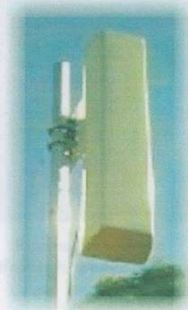
Figura 14: Painel setorial. Fonte: Kleber, 2007.
