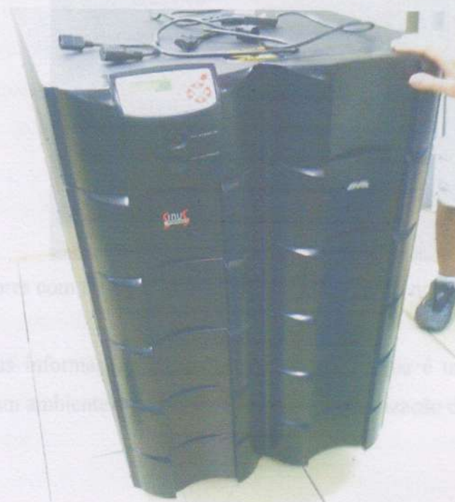
Figura 10 Nobreak Sinus Triphases no Data Center da UFRN (vista frontal)
