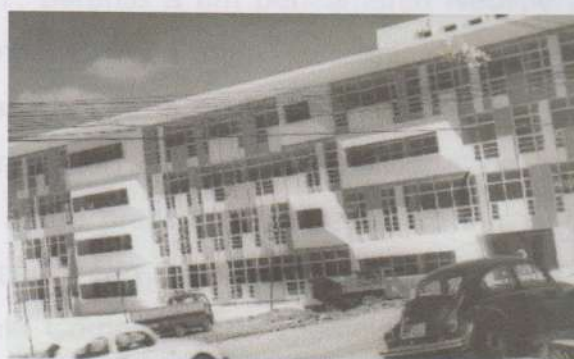
Foto 5 – Construção do prédio sede da Cosern Fonte: Acervo da Cosern
