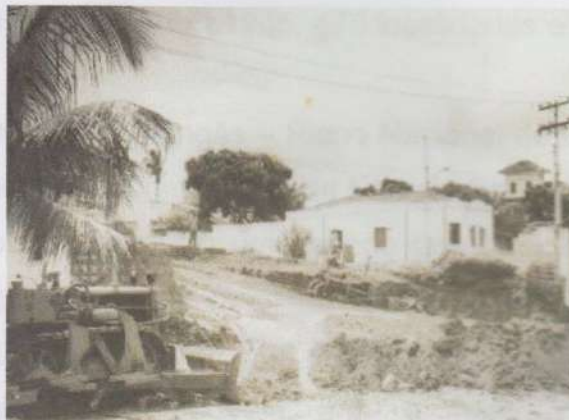
Foto 3 – Construção do prédio sede da Cosern Fonte: Acervo da Cosern
