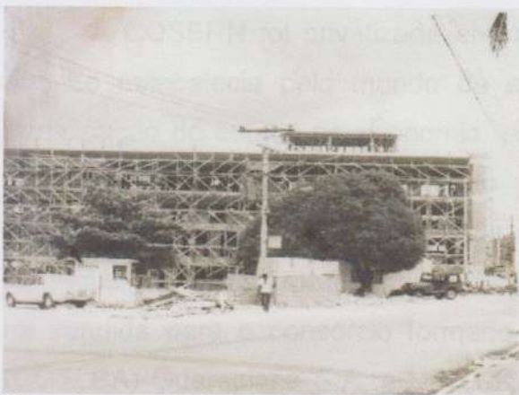
Foto 4 – Construção do prédio sede da Cosern Fonte: Acervo da Cosern
