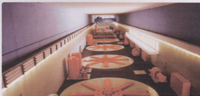
Figura 12 - Usina Hidrelétrica de Furnas
