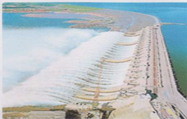
Figura 13 - Usina Hidrelétrica de Tucuruí - PA
