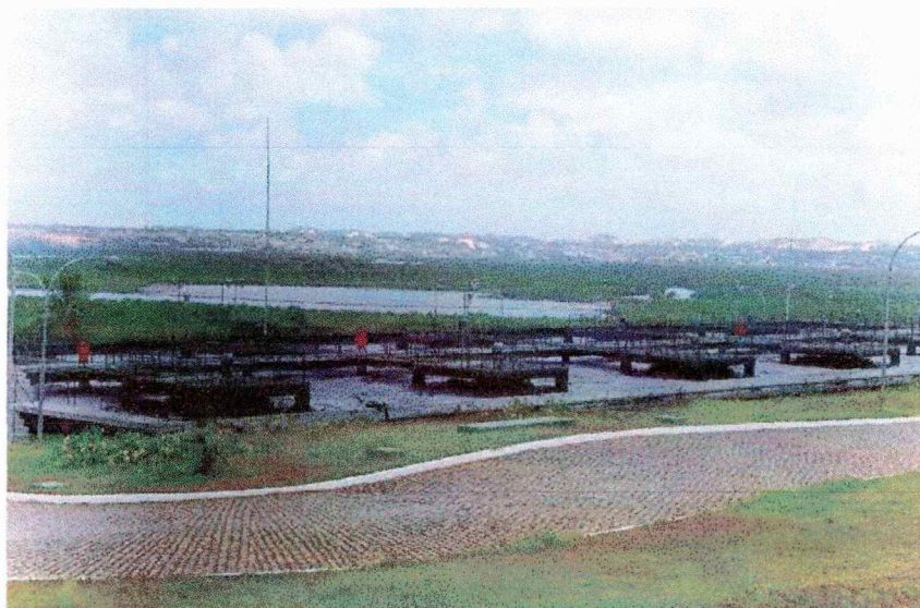
FIGURA 8 – VISTA PANORÂMICA DA ETE DA COTEMINAS. EM PRIMEIRO PLANO, O TANQUE DE AERAÇÃO E, AO FUNDO, O RIO POTENGI.
