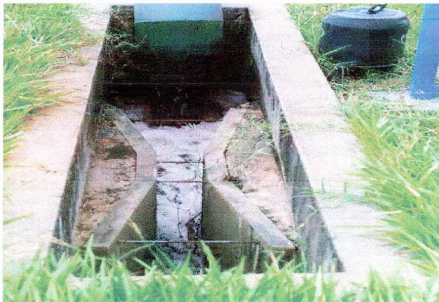
FIGURA 7 – DETALHE DA CANALETA, ATRAVÉS DA QUAL, APÓS O TRATAMENTO, OS EFLUENTES SÃO ENVIADOS PARA O RIO POTENGI.
