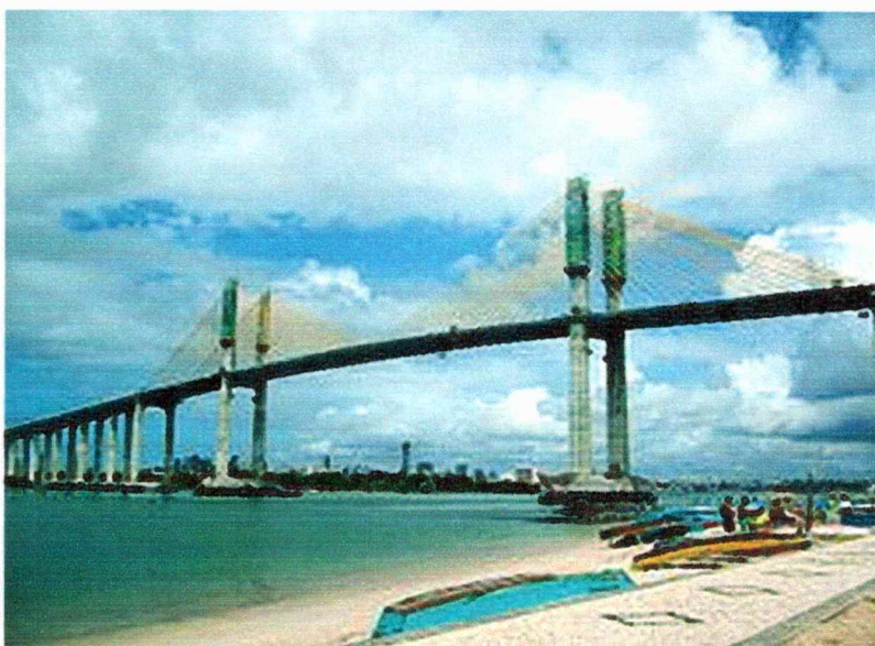
Figura 3: Ponte Newton Navarro no município de Natal-RN
