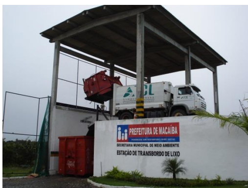
Figura 03 – Compactador abre a caixa de carga na Plataforma 01 e descarrega os resíduos no contêiner .
