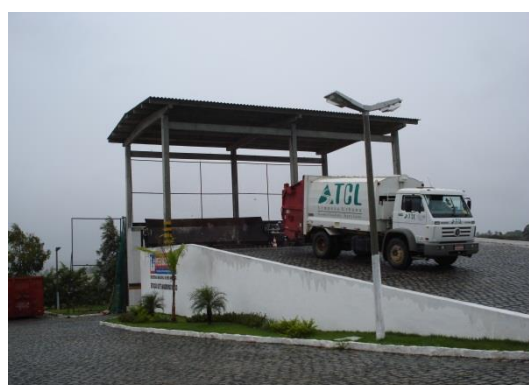
Figura 02 – Caminhão de coleta (compactador) sobe a rampa da plataforma 01.
