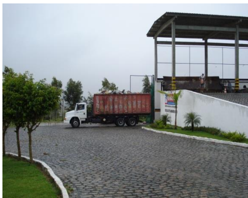
Figura 05 – O caminhão roll on-roll off retira o contêiner do fosso 01, após a descarga de 3 a 4 compactadores.
