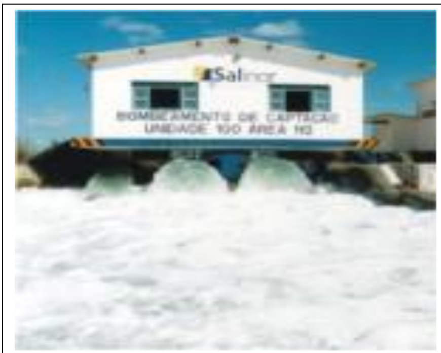
Figura 05: Foto da bomba de captação em funcionamento
